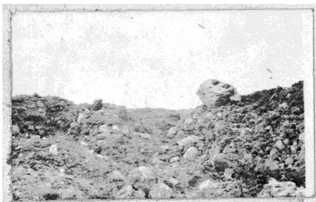
L'ouvrage de Thiaumont anéanti. © ECPAD - photo D86-198.
