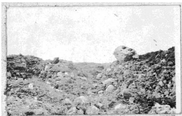
L'ouvrage de Thiaumont anéanti. © ECPAD - photo D86-198.
