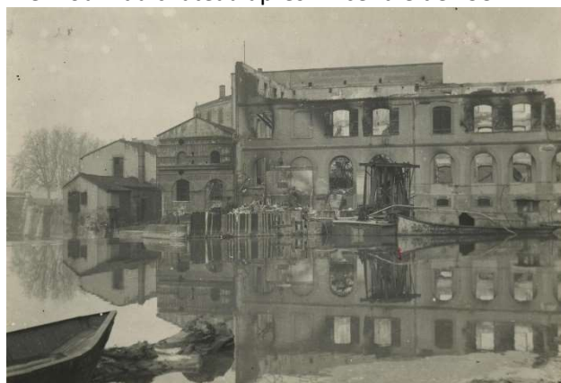
Le moulin du château après l'incendie de 1934
