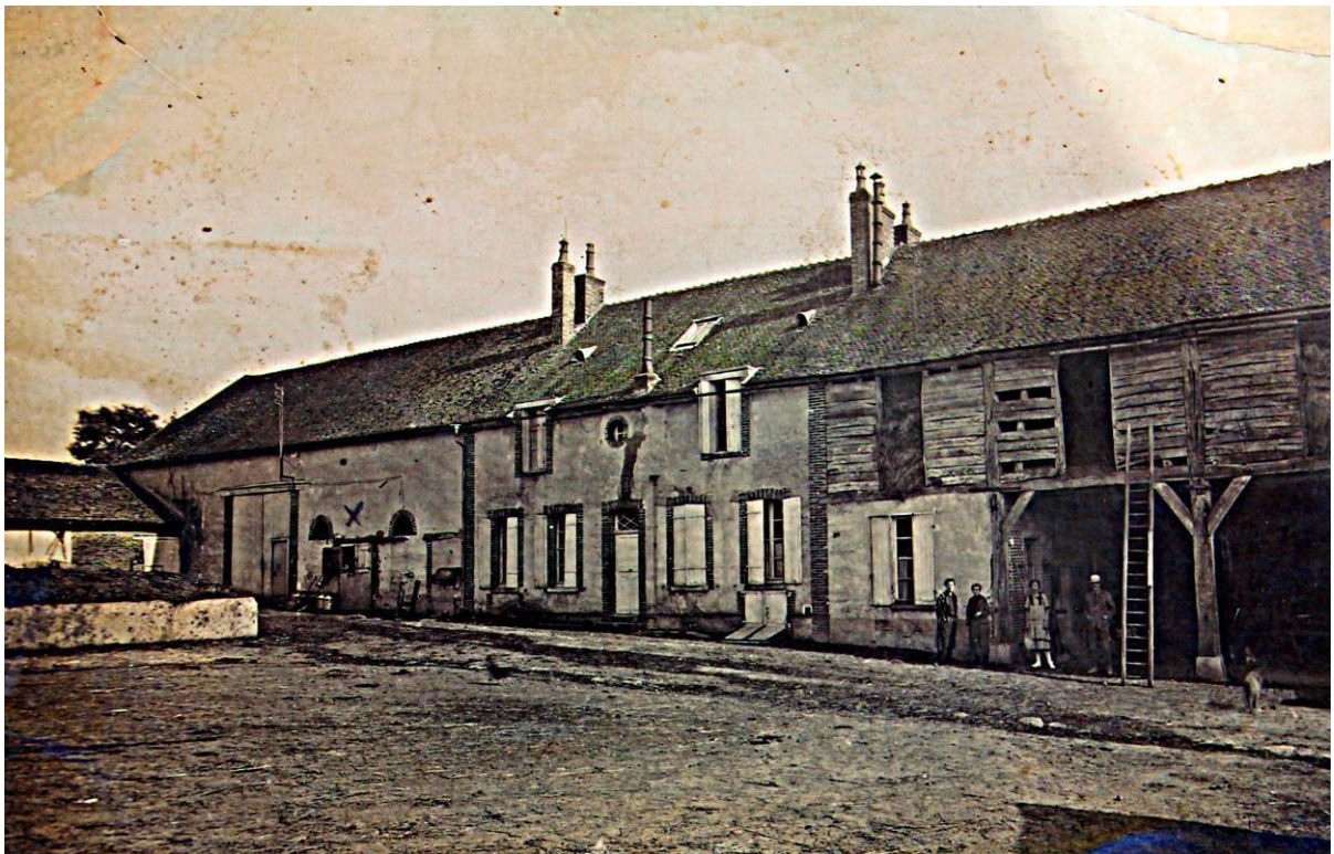
Photographie datant de 1888 environ, prise dans la cour intérieure de la ferme de la rue Henri Priou à Champlost
