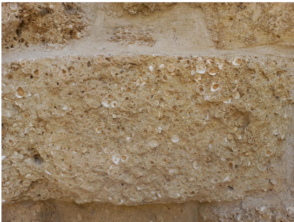
Figure 6: Photographie de pierre de constitution de l'église de Vic la Gardiole, en calcaire coquillier © MC. Walter
