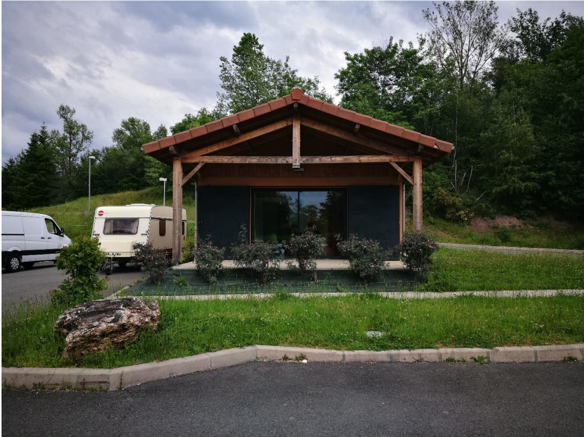
Photo 4 : Place de stationnement pour une famille sur l'aire d'accueil de Decazeville, mars 2017
