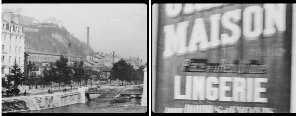
Figure 19 : Inconnu, Vue n° 130, Panorama de l'arrivée en gare de Perrache pris du train , de (00 :00 :10) à (00:00:21) – de gauche à droite
