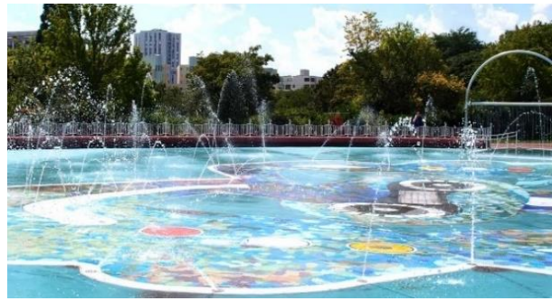
Figure 9 - Pataugeoire après rénovation (source : Diluvial, 2012)
