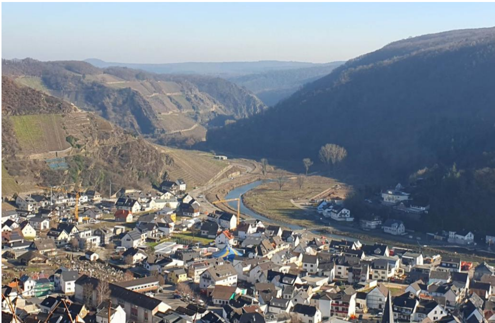
Figure 1 : Dernau, en pleine reconstruction, au cœur de la vallée encaissée de l'Ahr (photographie : S. Bouchenaki, 2023)
