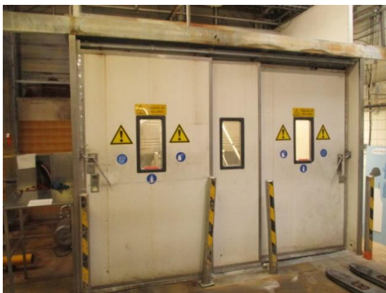
Figure 2 : Vue extérieure de la station process
