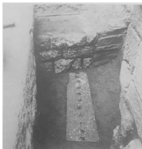
Figure 19 : Vue du canal extérieur à la porte du Silène, plaque de marbre avec trous de fixation d'une grille de fer, d'après GRANDJEAN 2011, p.187.
