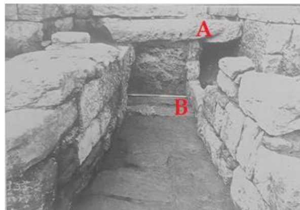
Figure 17 : Collecteur des eaux à la porte du Silène. A = dallage de la rue III, B = emplacement de la grille de protection, d'après GRANDJEAN 2011, p187.
