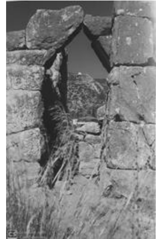
Figure 30 : Poterne en arc brisé de Palairos, d'après HELLMANN 2010, p.340.
