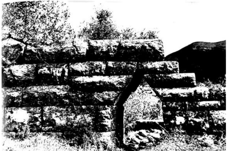
Figure 3. Photographie d'une poterne de l'enceinte de Messène, d'après ADAM 1982, p.96
