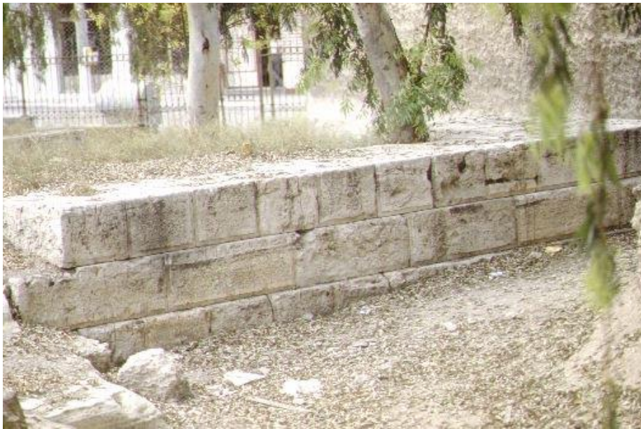
Figure 1. Restes de la porte de la ville du Pirée, rénovée sous Conon, photographie de DANIELS M., juin 1990.
