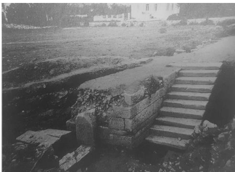
Figure 2. Photographie de la porte oblique vue du sud, d'après GRANDJEAN 2011, p.285.
