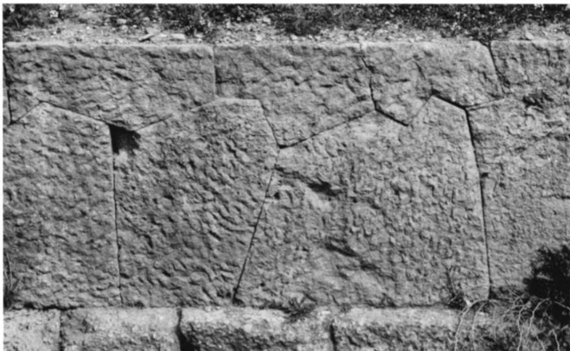
Figure 2. Photographie de l'appareil en dent de scie à la tour nord de la porte ouest d'Érétrie (on voit en-dessous le socle de l'élévation de la tour), d'après FACHARD 2014, Pl.4.
