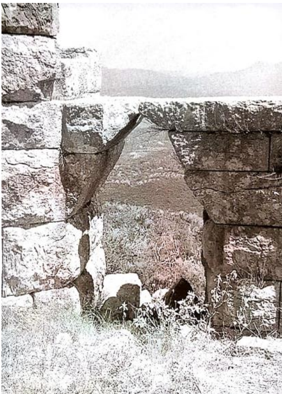
Figure 2. Photographie d'une poterne de l'enceinte de Messène, d'après ADAM 1982, p.95.
