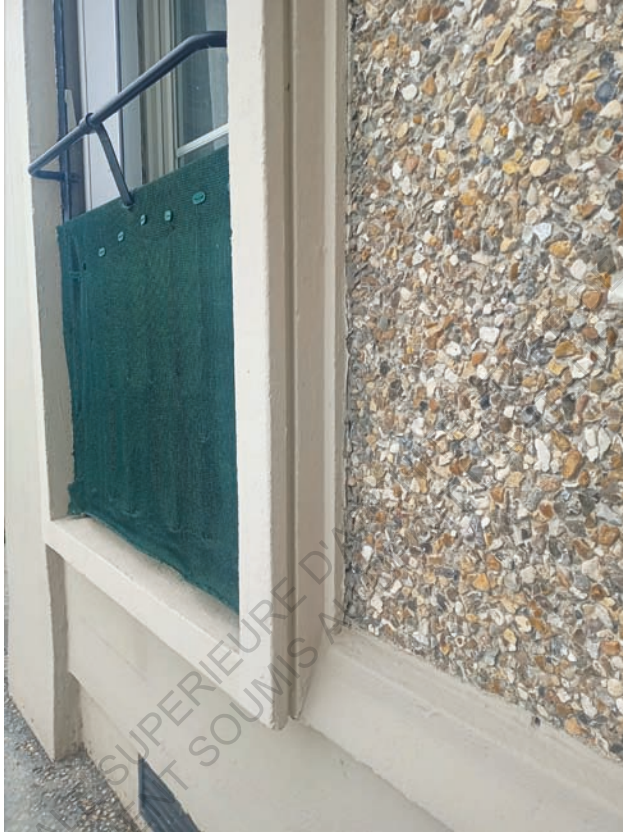
Photo d'une ouverture au RDC de l'îlot N20 sur le front de mer Ouest.
