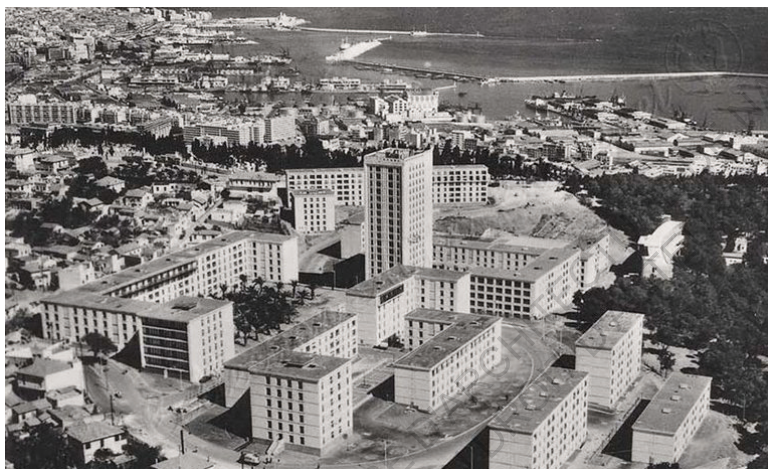
Photo aérienne, vue générale de l'ouvrage 112 .
