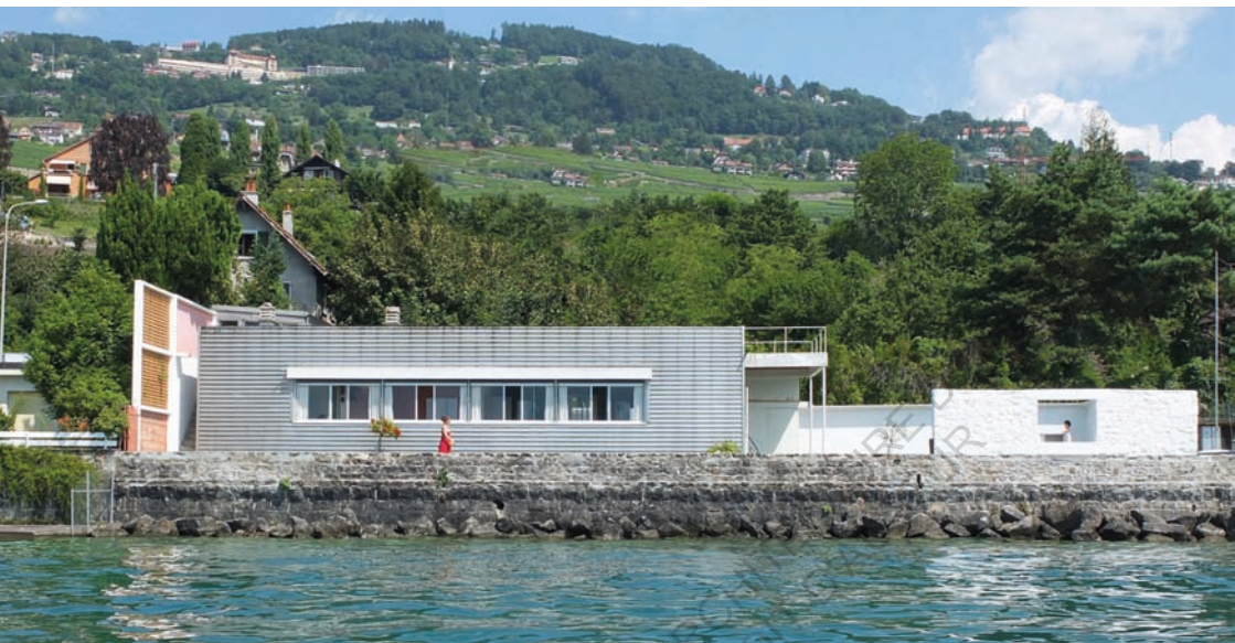
Photo : vue de la façade principale de l'ouvrage, donnant sur le lac, Corseaux, Suisse 131 .
