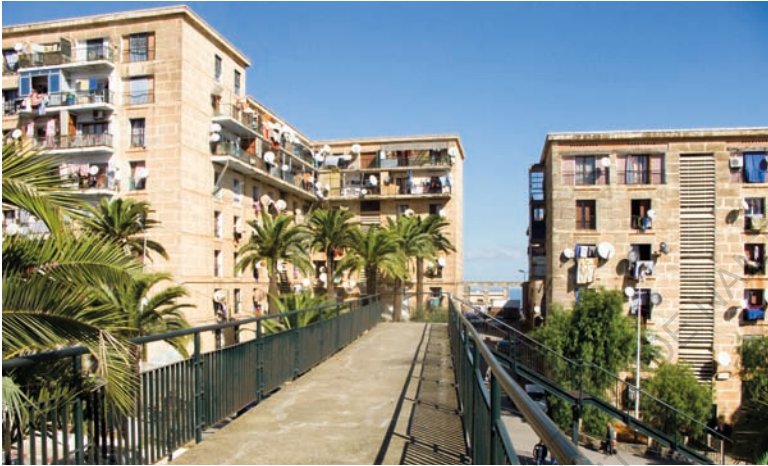
Photo depuis la passerelle, vue des ensembles bâtis 115 .
