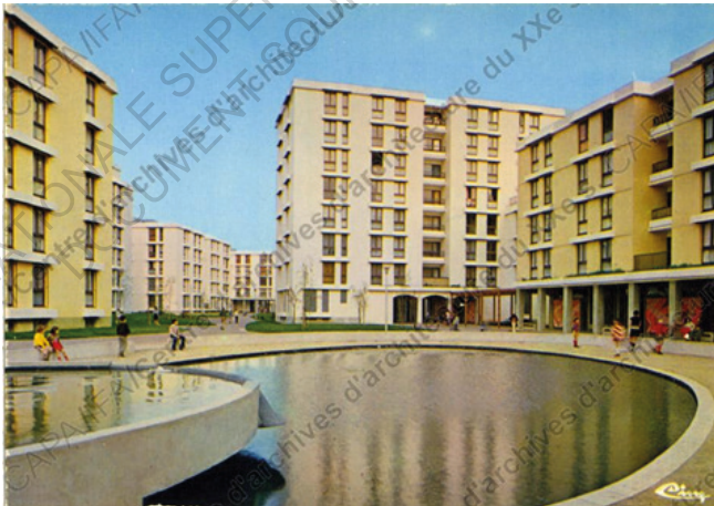
Photo de l'ensemble des Hautes-noues, Villiers-sur-Marne. Archive de la cité de l'architecture.
