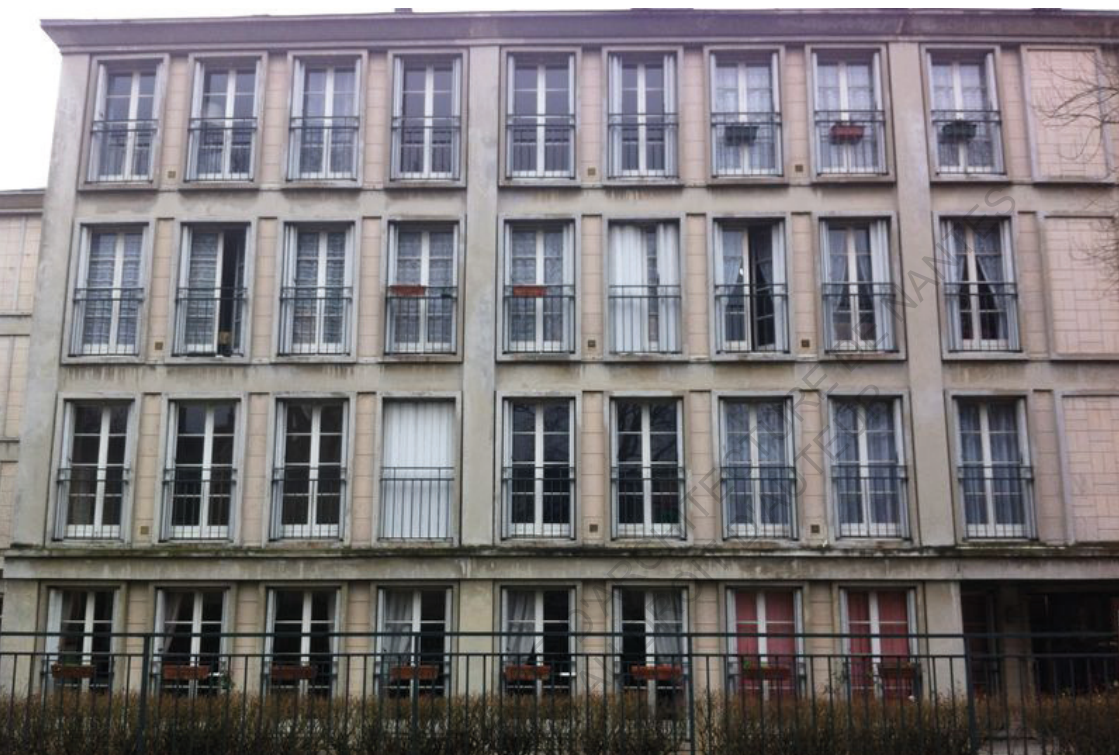
Photo des façades de l'ouvrage avant sa rénovation. 84
