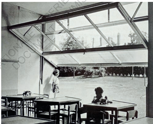
Photo, vue du rez-de-chaussée de l'école maternelle, ville haute, Le Havre 154 .
