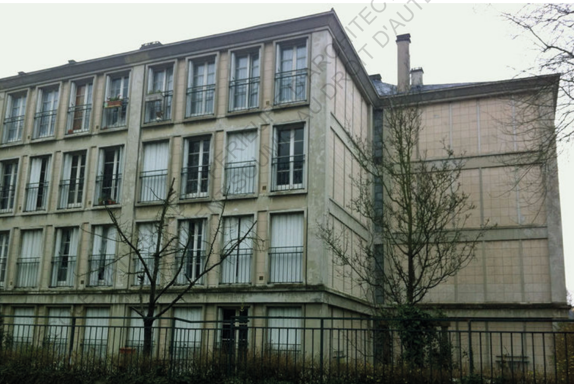
Photo des façades de l'ouvrage avant sa rénovation. 83
