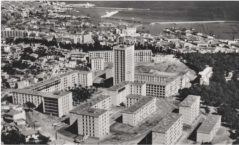
Photo aérienne, vue générale de l'ouvrage 112 .
