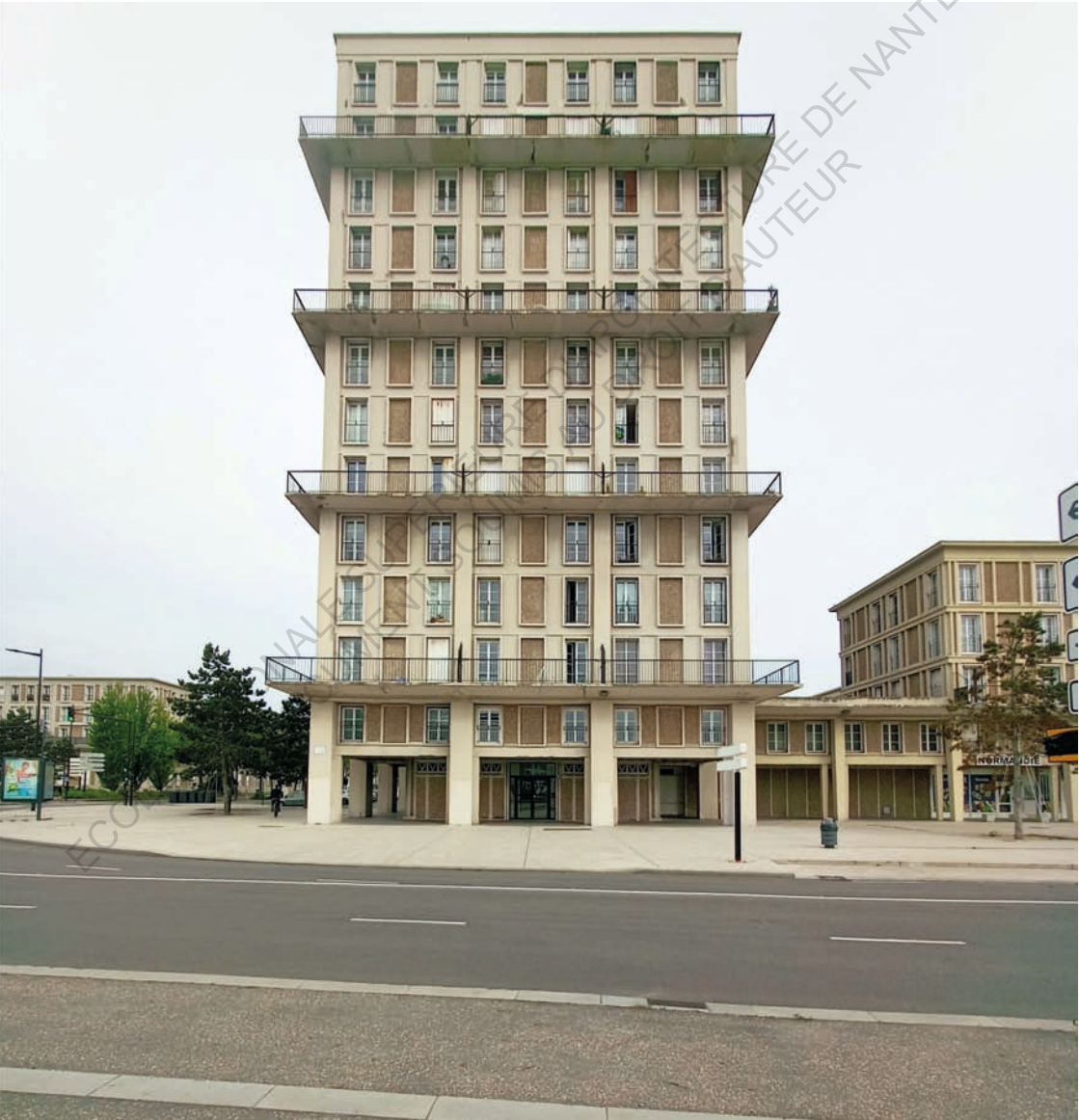
Photo de la tour d'habitation de l'îlot N37, aux abords du Grand quai, au sud du centre-ville.
