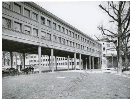
Photo, gauche : bâtiment de classe avec partie en porte-à-faux. 71
