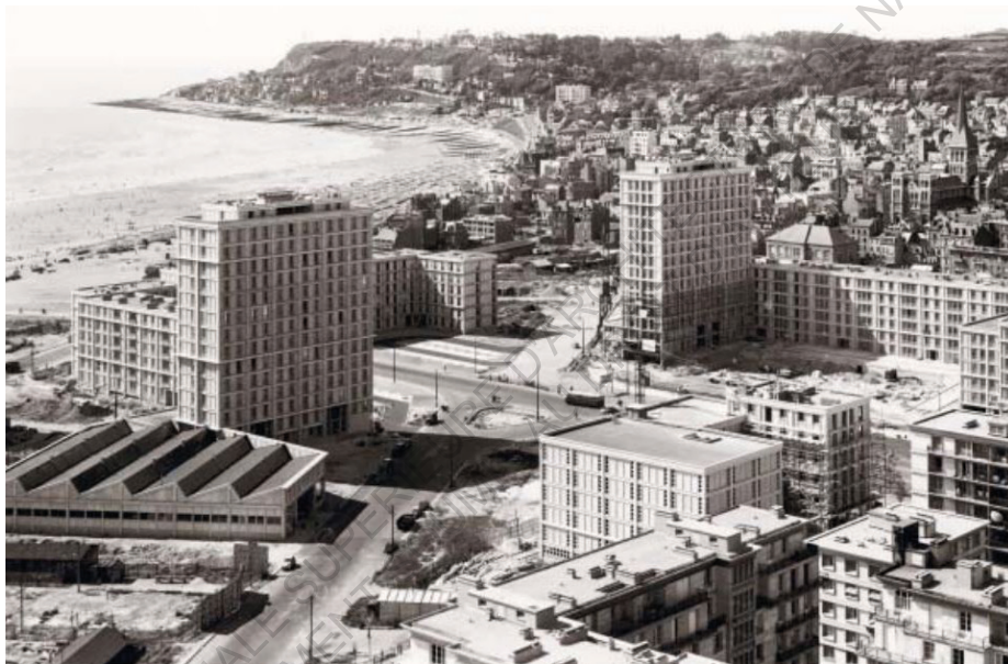
Photo : Vue aérienne de la porte Océane, Le Havre 179 .
