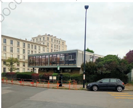
Photo du bâtiment Ouest, vue depuis le quai de l'Arsenal, Le Havre.
