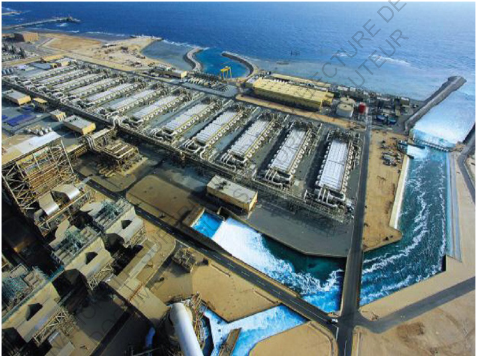
Fig 57 - Image de l'usine de dessalement de l'eau à Israël
