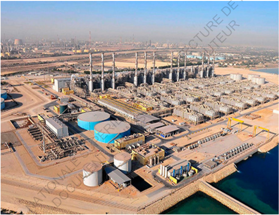
Fig 58 - Image de l'usine de dessalement de l'eau en Egypte
