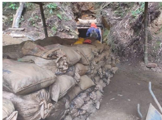
Photo 11. Entrées de mines soutenues par des piliers en bois sur la concession Melina. Photo : FAP, le 21 décembre 2020
