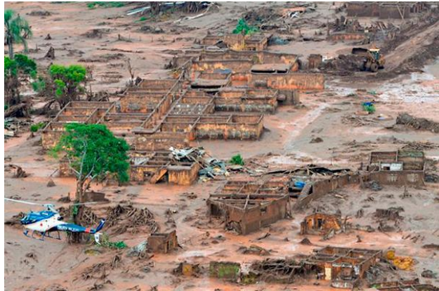
Photo 4. Rupture d'une digue à résidus de la société minière Samarco, au Brésil. Photo : Tiempo Minero J.V, le 12 juillet 2021
