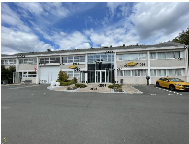
Figure 17 : Positions des points de contrôle levés sur la façade (Source : production personnelle)
