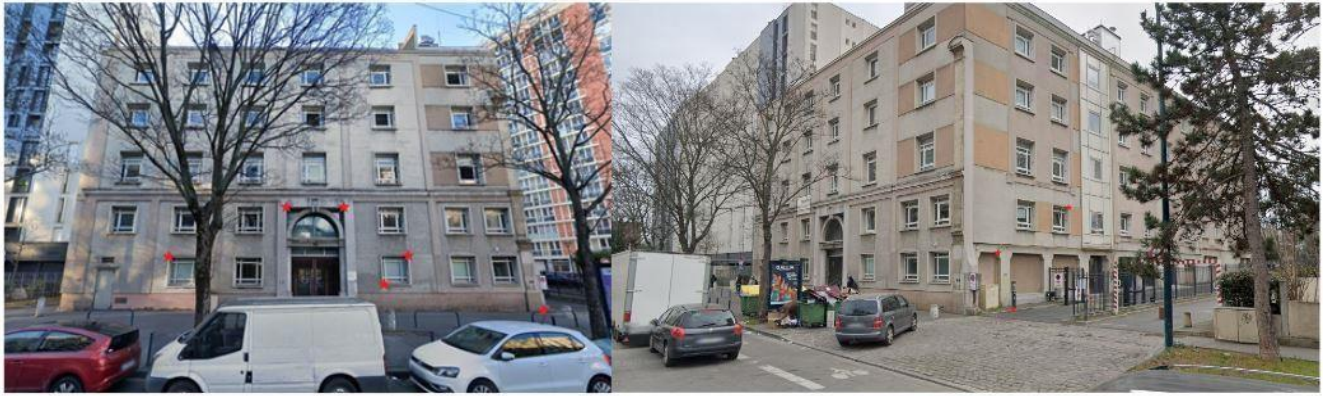
Figure 19 : Positions des GCP levés sur la façade à modéliser (étoiles rouges)
