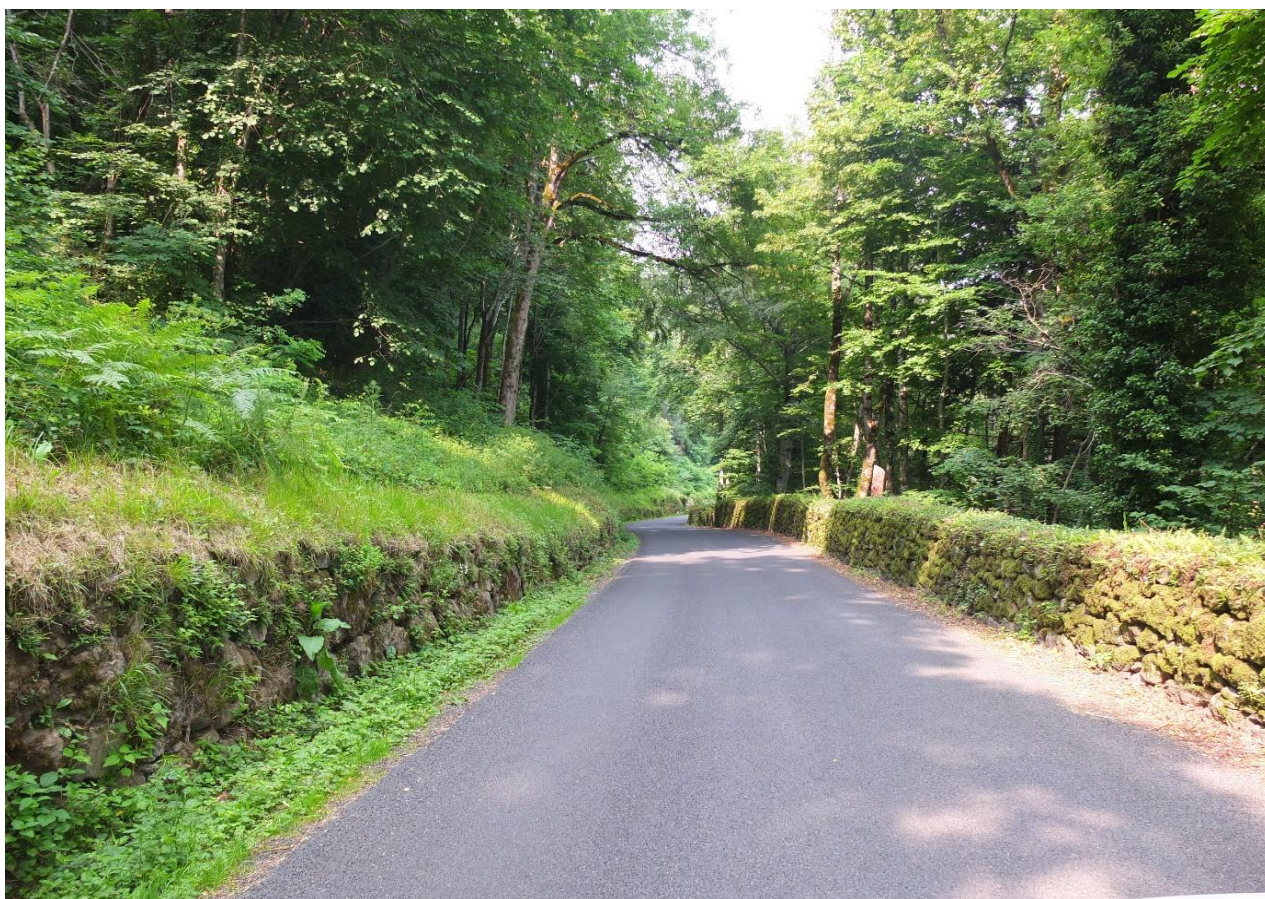
Figure 48. Murs de soutènement intemporels naturellement drainant, refuge de biodiversité, et parapets couverts de mousses, les constructions en pierres sèches font partie de l'identité des routes sinueuses des flancs de vallées au Pays de Salers. ML 2023.
