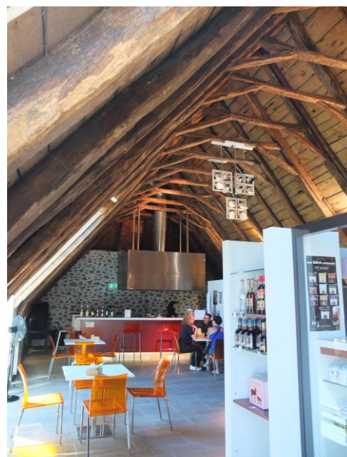
Figure 18. Photographie de l'intérieur de la Maison de la Salers. La charpente de cette grange traditionnelle a été conservée. ML 2023.
