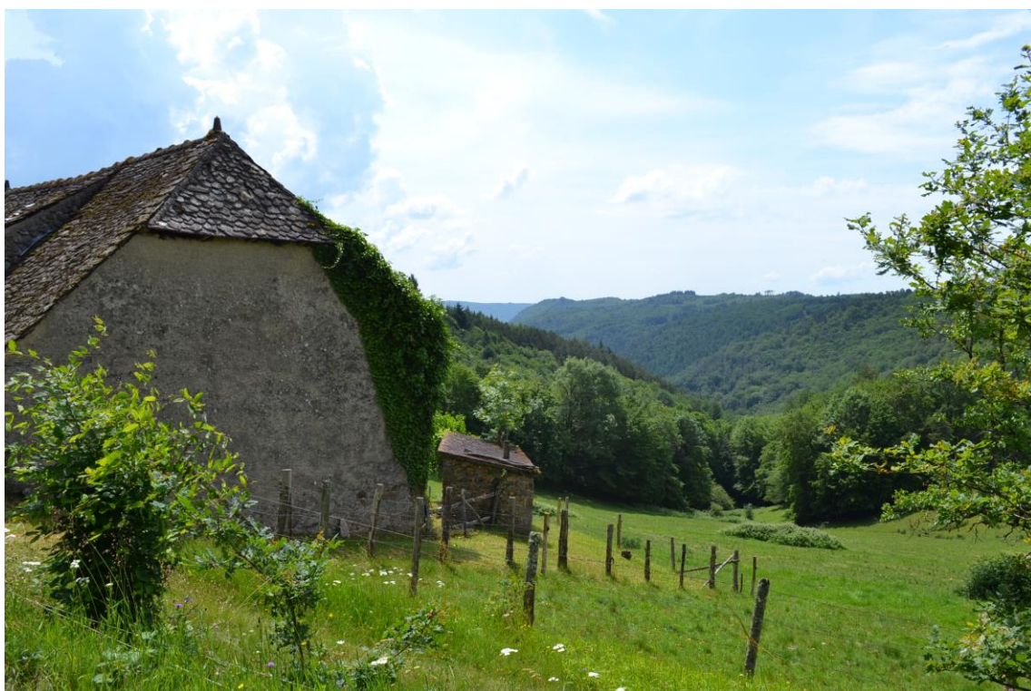
Photo 3 : Ferme de Xaintrie au toit de lauzes, entre Neuville et Argentat-sur-Dordogne (prise de vue : Myrtille SCHLUR, 6 juin 2023)
