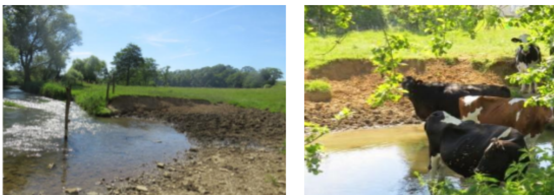
Figure SEQ Figure 1* ARABIC 13 : Dégradation de berge par le bétail (H.Hissler, 2021)
