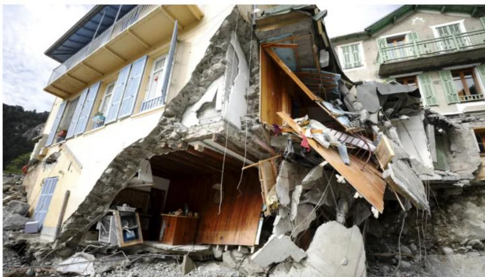
Dégâts sur la commune de Saint-Martin-Vésubie suite à la tempête Alex. © Maxppp - Dylan Meiffret
