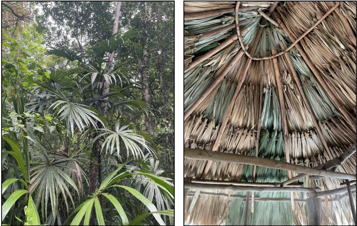
Figure 25 – Photographies des feuilles de Sabal Mauritiiformis composant les toitures végétales des habitations mayas
