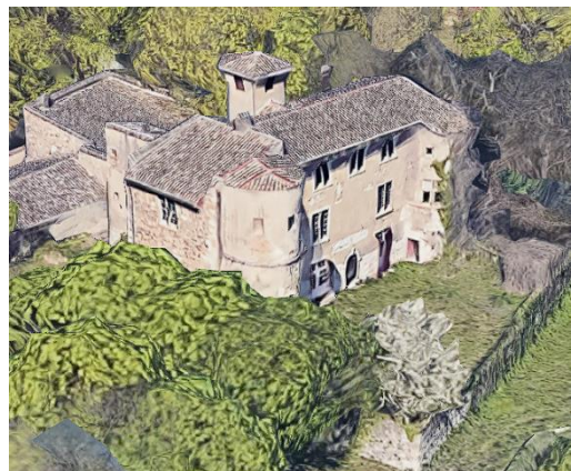
Figure 19 : Vue Sud du Chatelard en 2023
