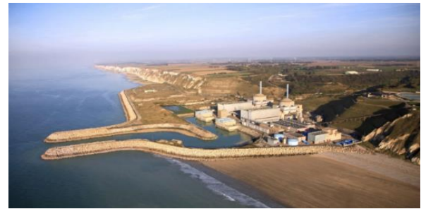
Figure 43 : Photo prise par un drone aérien de la centrale et chenal de Penly (extrait d'un rapport de fin d'intervention dans le chenal de Penly effectué par INGENIO effectué le 15/05/2021)
