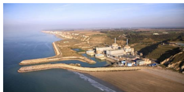
Figure 43 : Photo prise par un drone aérien de la centrale et chenal de Penly (extrait d'un rapport de fin d'intervention dans le chenal de Penly effectué par INGEO effectué le 15/05/2021)
