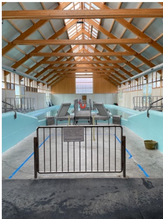
Figure 7 : Vue d'ensemble de la piscine du CIRALE de l'EnvA (crédit EnvA)
