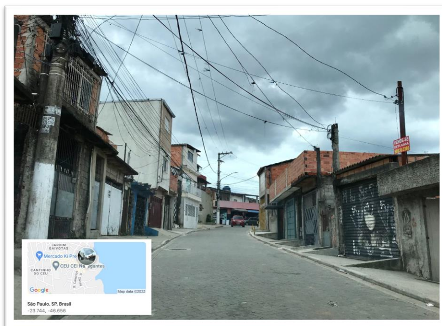
Figure 16. Murs extérieurs non enduits et câblage électrique enchevêtré au Cantinho do Céu.
