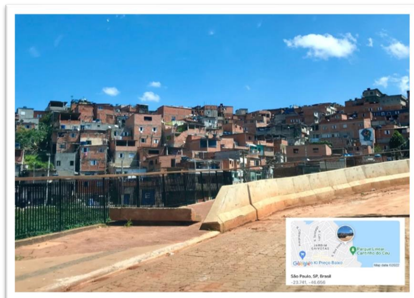
Figure 14. Vue à partir de la portion sud du Parc Linéaire.
