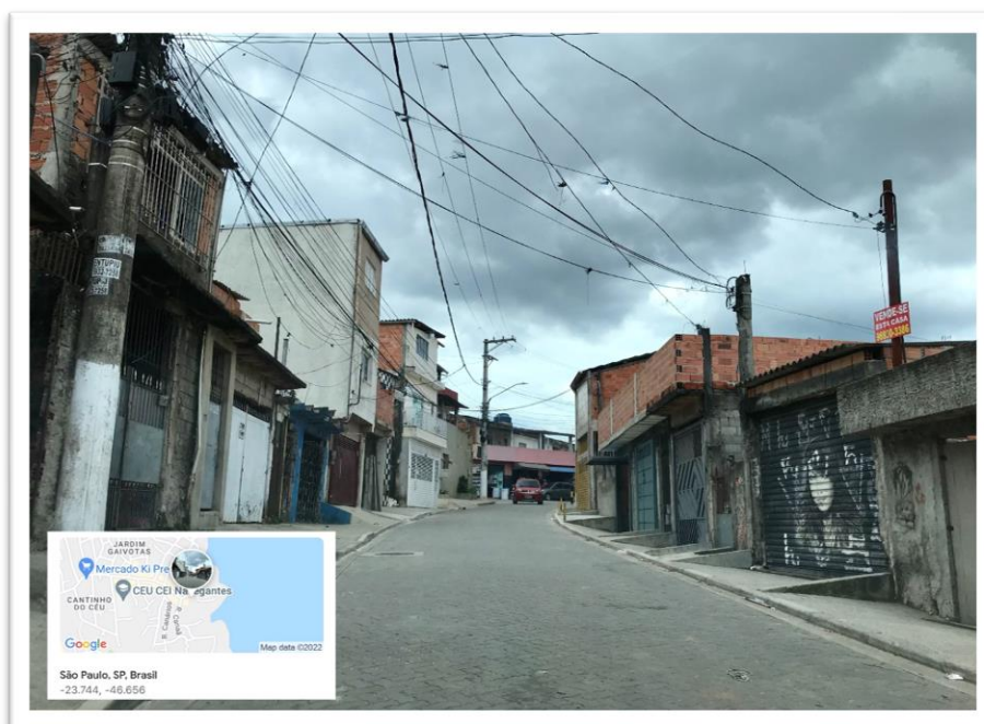
Figure 16. Murs extérieurs non enduits et câblage électrique enchevêtré au Cantinho do Céu.
