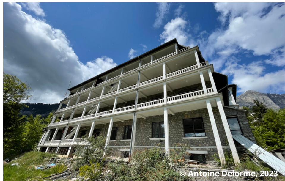
Figure 20 : Vue arrière du bâtiment du Roc des Fiz
