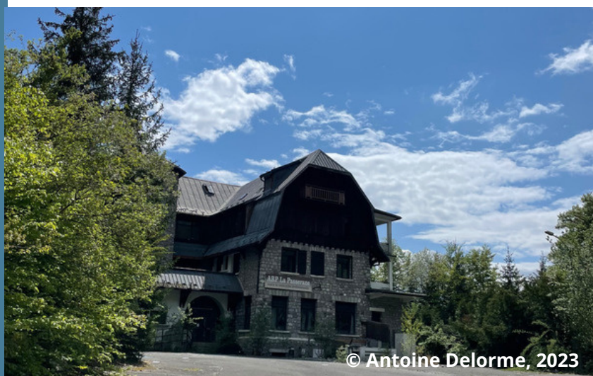
Figure 19 : Bâtiment du sanatorium du Roc des Fiz abandonné
