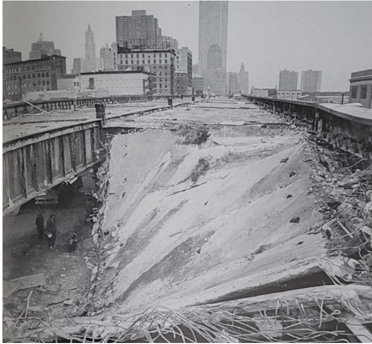
Image 53. Photographie de l'effondrement d'une partie de la West Side Highway en décembre 1973 (source : Harry Hambourg / New York Daily News Archive / Getty Images).
