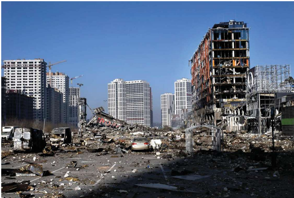
Illustration 23: Centre commercial Retroville à Kiev, le 21 mars 2022, en Ukraine, détruit par une rocket russe, huit personnes sont mortes. Photographie : Guillaume Herbaut / Agence Vu'
