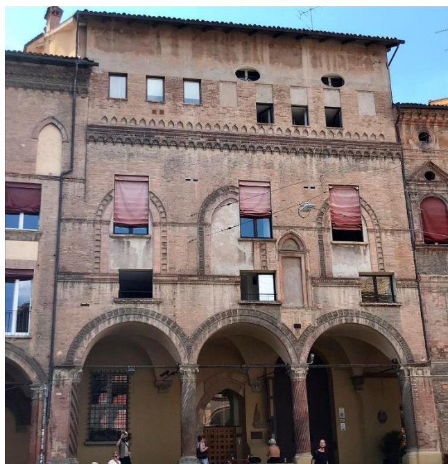
Figure 69 - Réhabilitation d'un bâtiment ancien à Bologne, piazza Santo Stefano (source : Antoine Deltheil)
