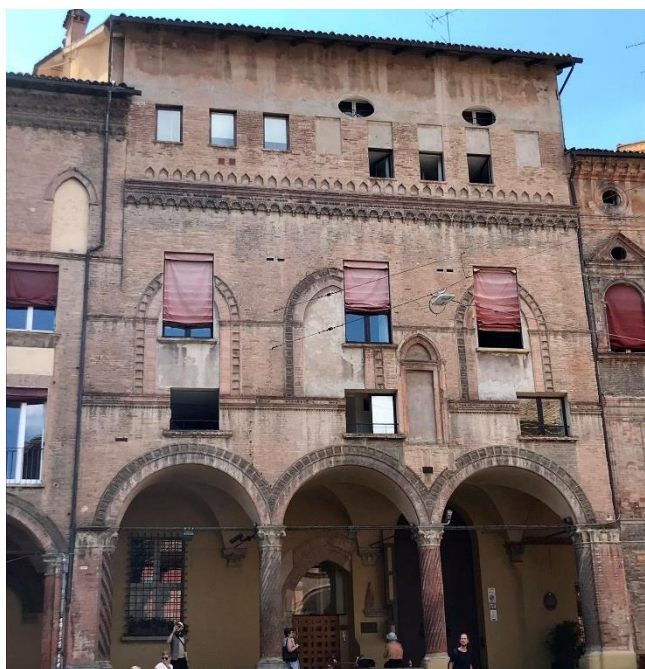
Figure 69 - Réhabilitation d'un bâtiment ancien à Bologne, piazza Santo Stefano (source : Antoine Deltheil)
