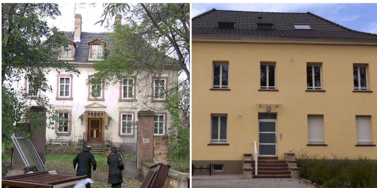
Figure 71 - Exemple de rénovation énergétique ayant pour effet une perte patrimoniale et une altération architecturale (source : Carole Pezzoli via ANABF)
