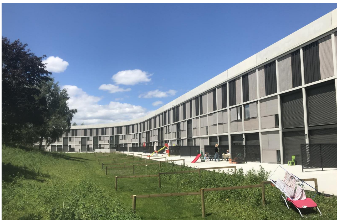
Figure 74 - Réhabilitation du bâtiment de La Corniche à Firminy par Yann Olivares et Frédéric Busquet en 2009 (source : https://www.prixnational-boisconstruction.org/les-laureats/palmares-precedents/6391 )
