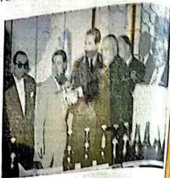
M. Kyriakis Anghelopoulos, dans la salle de soutirage de la Bière, donne au Diadoque des explications sur le fonctionnement de la remplisseuse et de l'étiqueteuse automatiques. On remarque à l'entrée plus, à droite, l'Administrateur de l'Usine.
