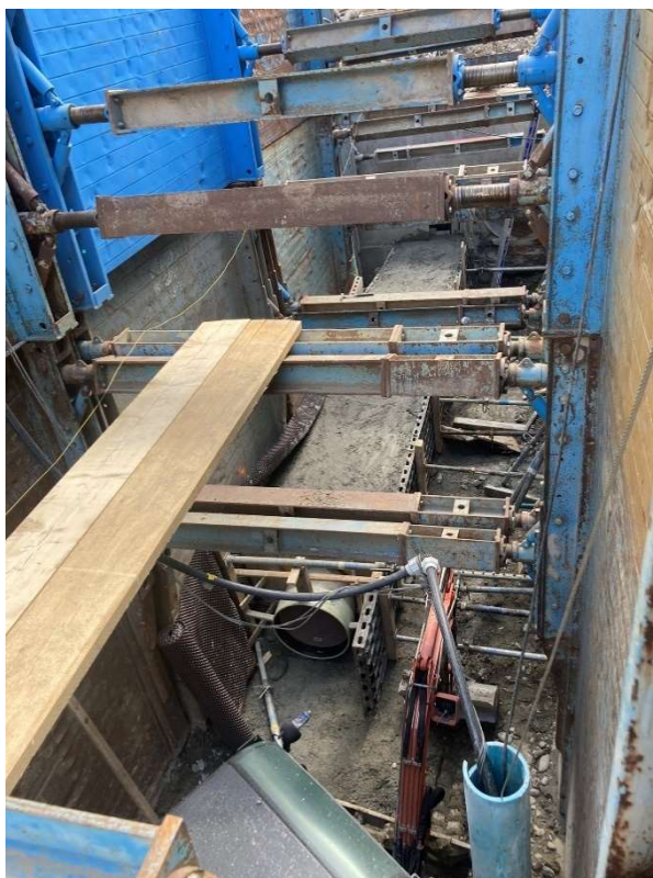
Fig. 21 : Fouille ouverte du BPDA avec puits crépinés
