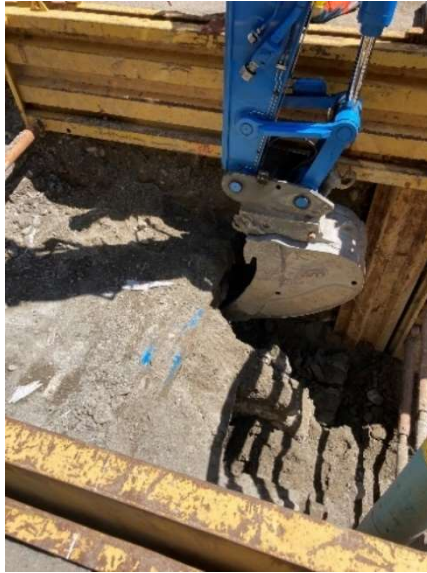
Fig. 14 : Excavation sur chantier dans un cadre « Gigan » (Induni)
