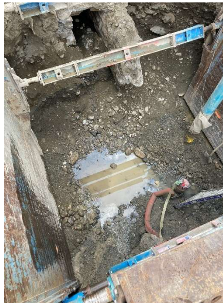
Fig. 11 : Coupe de la fouille avec collecteur à détruire (SDIG) et photo du collecteur en cours de démolition entre les étais à droite (Photo Y. Collomb)
