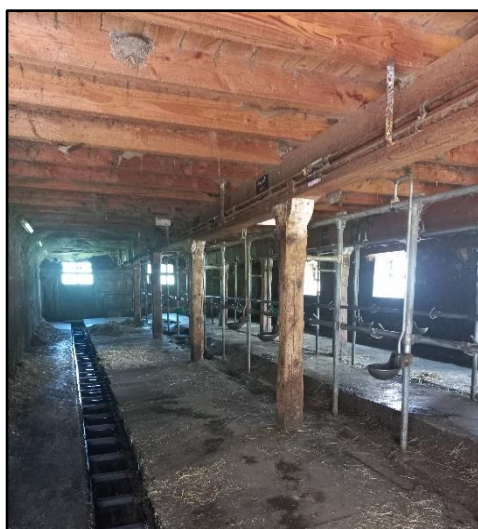
Figure 6: Salle de traite en entravée
