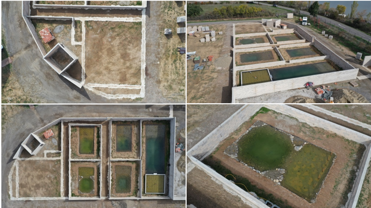
Figure 26 : Photographies aériennes de la station d'élevage et d'étude en cours de construction - © Fred Lavail
