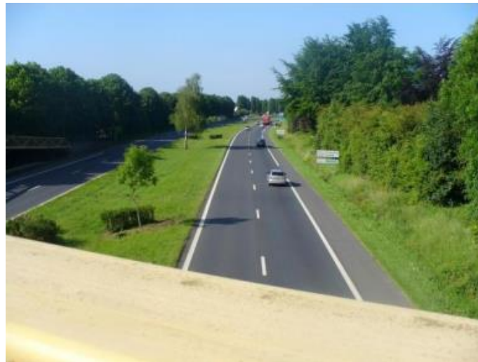
Figure 16 : La passerelle. Parcours iconographiques comparés à Hérouville Saint-Clair (les cheminements) , Paysages des mobilités ordinaires : éduquer au regard en géographie scolaire. 2018.
