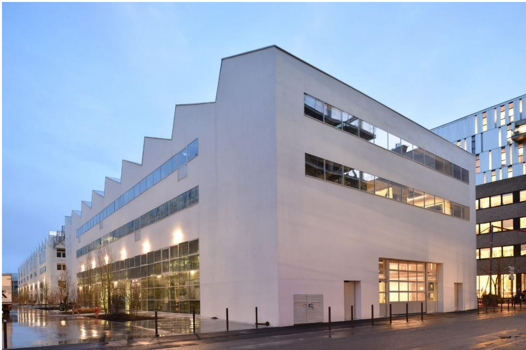
Annexe 2 : Billaud, Jean-Dominique et Samoa, Halle 6 est - Hôtel d'entreprises numériques et créatives , photographie, Île de Nantes, 2019.
