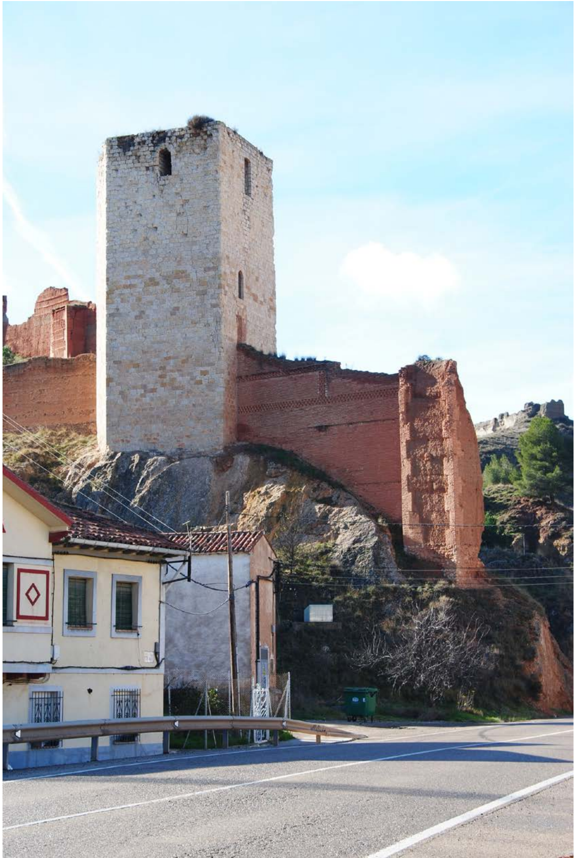
Enceinte fortifiée en pisé avec pilier de briques crues et cuites structurel. Daroca, Aragon. Photos personnelles - 2021
