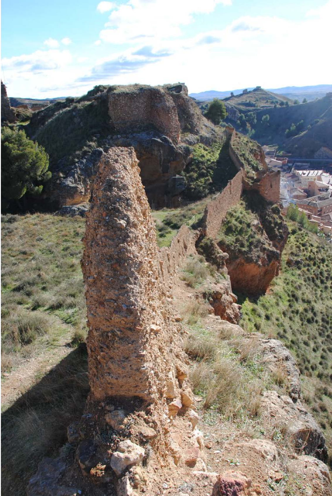
Enceinte fortifiée en pisé de Daroca, Aragon. Photos personnelles - 2021
