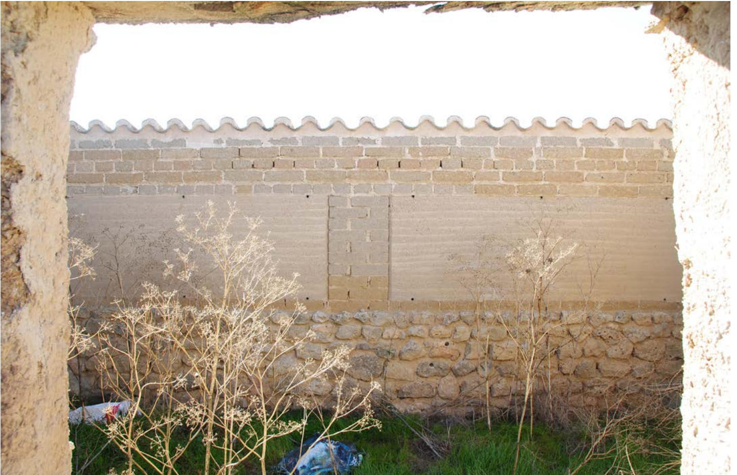
Autre technique plus contemporaine du encadenada (date inconnue). Photo personnelle 2021. Ce mur présente un soubassement en pierre et des piliers en briques (ce qui semble être de la brique de terre comprimée). Le pisé sert alors plutôt de remplissage.
