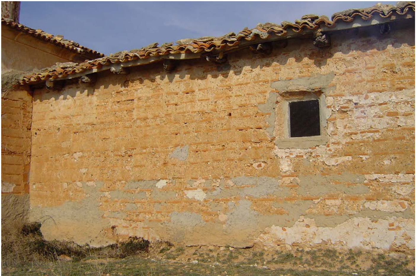
Ermite El Carrascal, Saragosse. 18ème siècle. Technique mixte de pisé avec tuile cuite intégrée et enduit «calicostrada»
