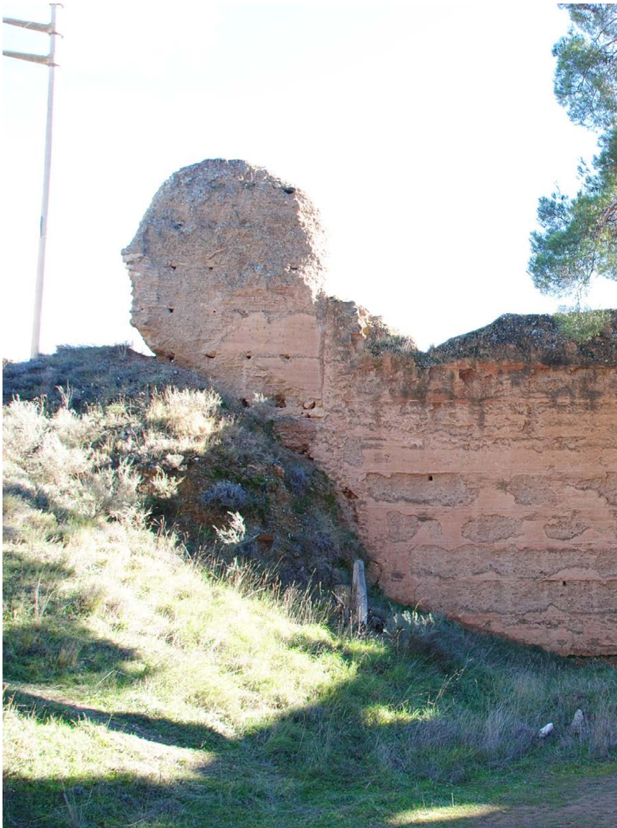
Enceinte fortifiée de Daroca, Aragon. Technique du calicostrada. Photo personnelle 2021.
