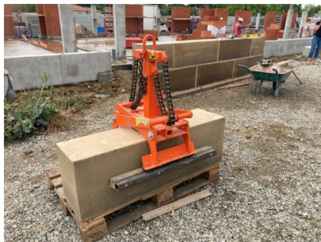
Figure 36 : réalisation des mégas BTC pour le projet carré flore, sources : Ecozimut
