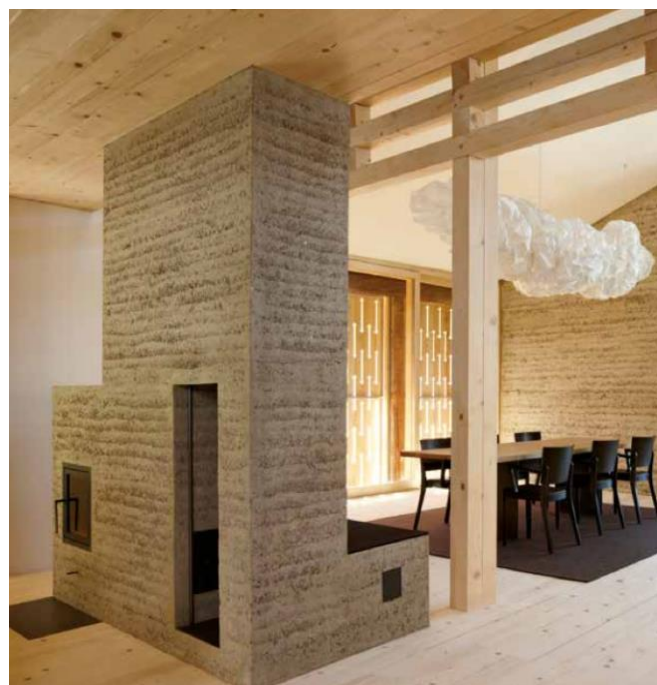
Figure 3 : Utilisation de l'inertie du pisé, Maison Piazza Pintgia, Almens, Suisse 2013, Maître d'oeuvre : gujan + pally architekten, Réalisation : Martin Rauch
