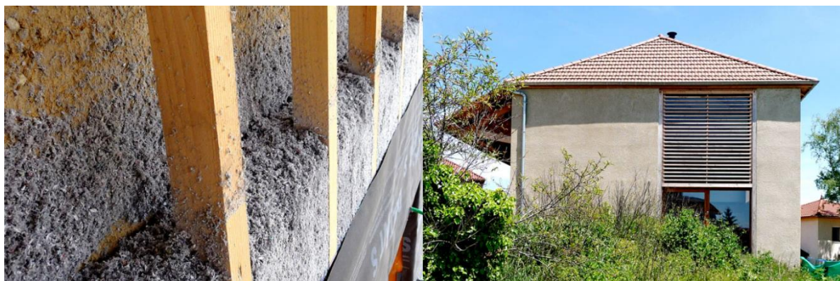
Figure 26 : Isolation ouate de cellulose projetée, source et crédits photos : Caracol
