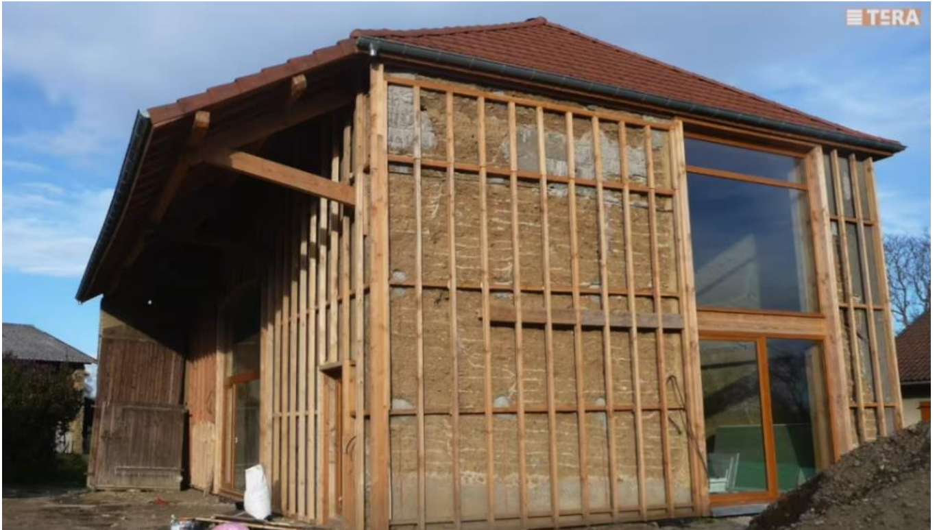
Figure 27 : Isolation ouate de cellulose projetée, source et crédits photos : Caracol
