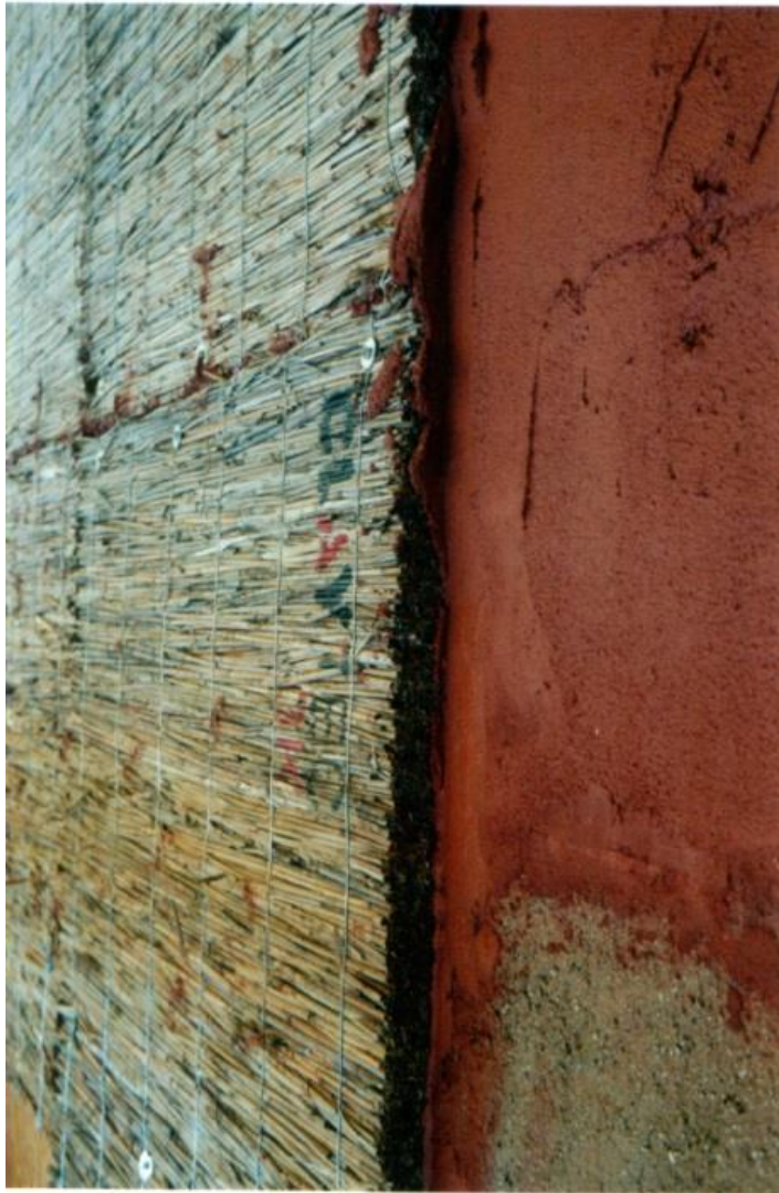
Figure 30 ; Maison ITE roseaux, source et crédits photos : Martin Pointet
