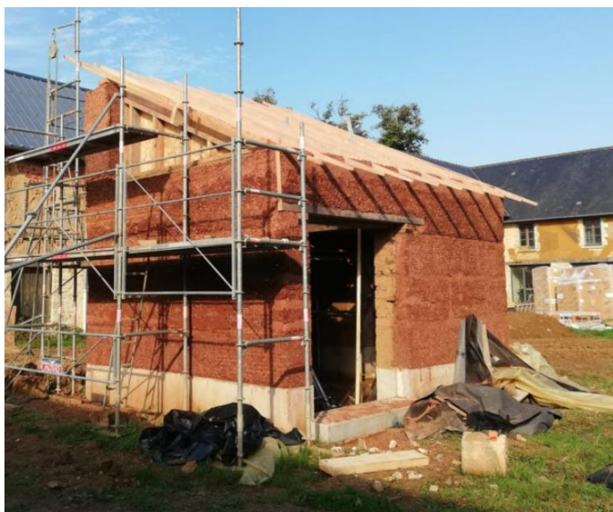
Figure 37 : Projet pilote Cob bauge, source : site internet Cob bauge
