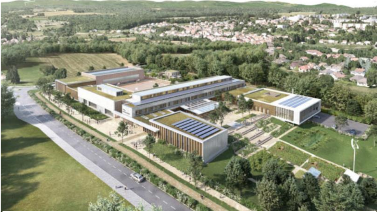
Figure 43; Collège innovant de Béthoncourt, source : CRR architecture
