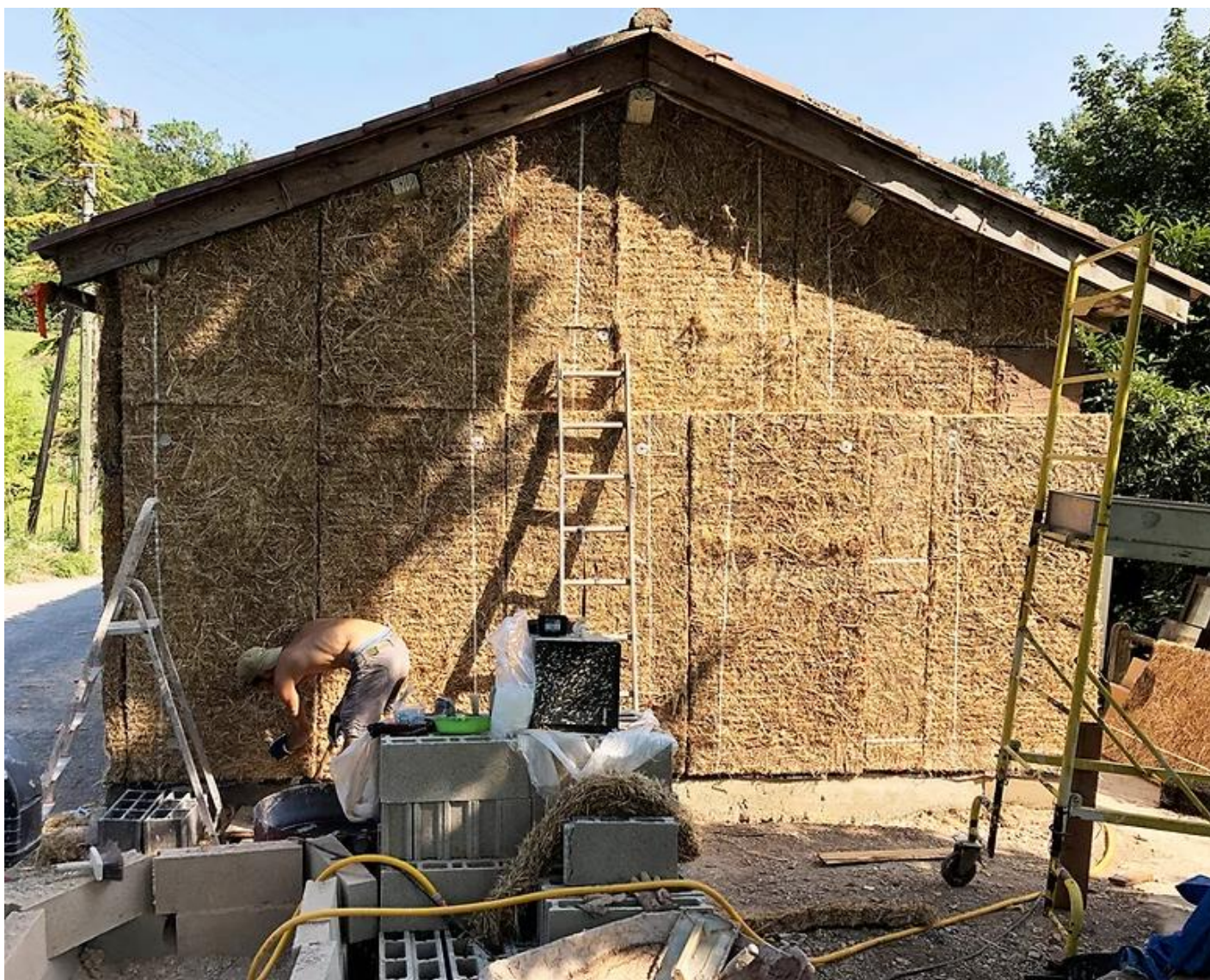
Figure 45 Image correspondant au chantier de rénovation d'une maison dans l'Aveyron avec Copano (même technique d'isolation que pour le projet la gaiété), source : site internet Copano
