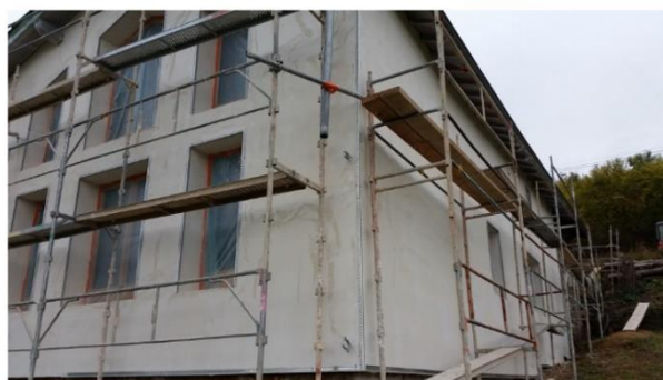
Figure 22 : Rénovation Brullioles, Source : espace info énergie, crédits photos : Domébio
