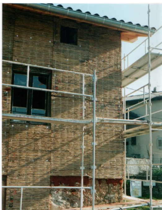
Figure 28 ; Maison ITE roseaux, source et crédits photos : Martin Pointet
