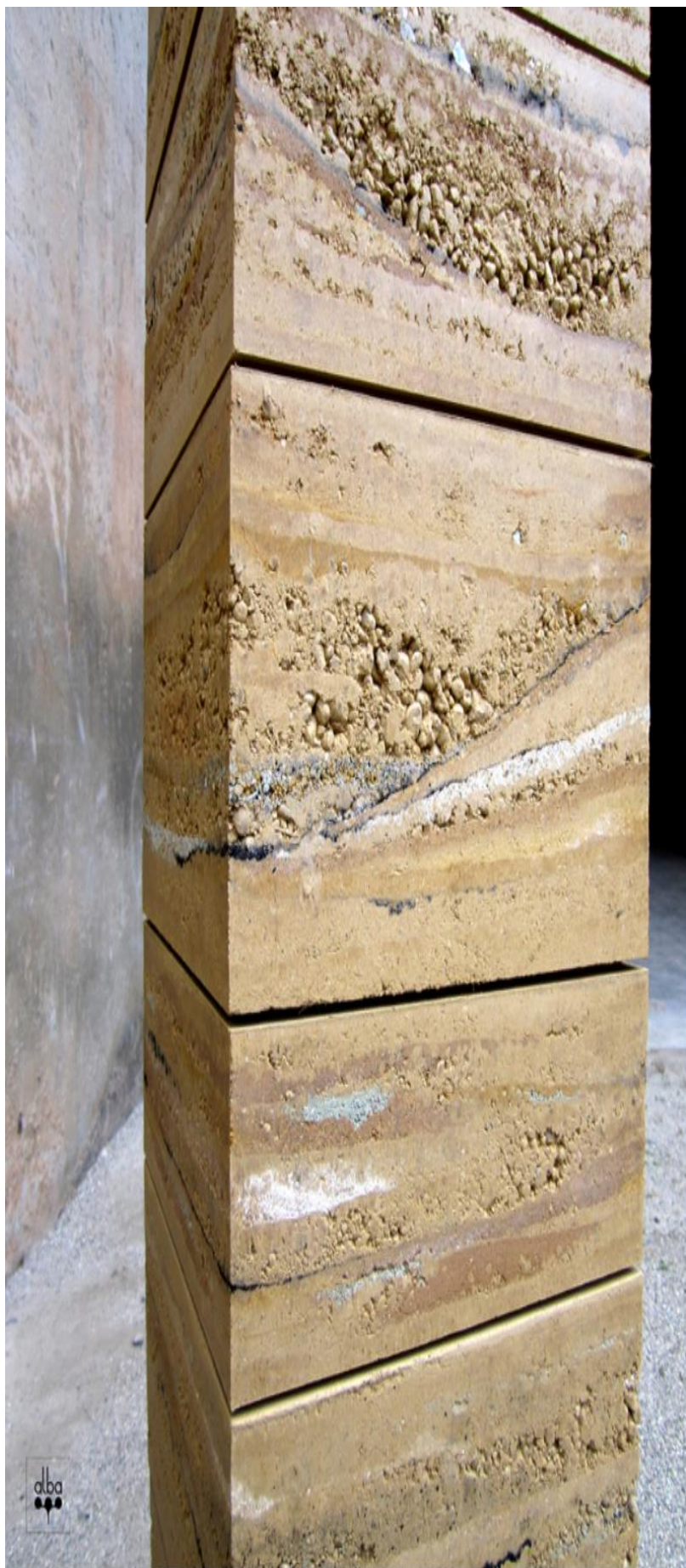
Figure 8 Le pisé un matériau poreux, Source : site internet Amàco, L'esthétique de strates du pisé est sublimé par des jeux de couleurs. Auteur de l'œuvre : Atelier Alba.
