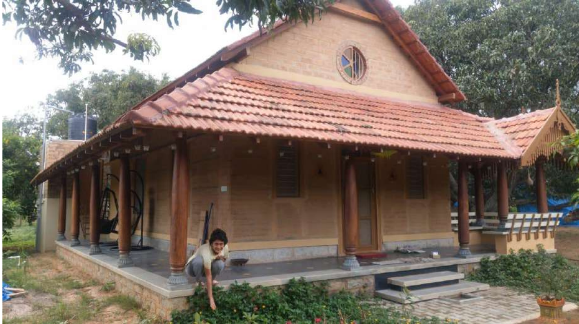
Fig 23: Vue d'une résidence en pisé à Bangalore, en Inde.
