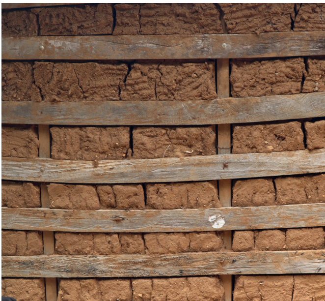
↑ Murs en torchis locale
