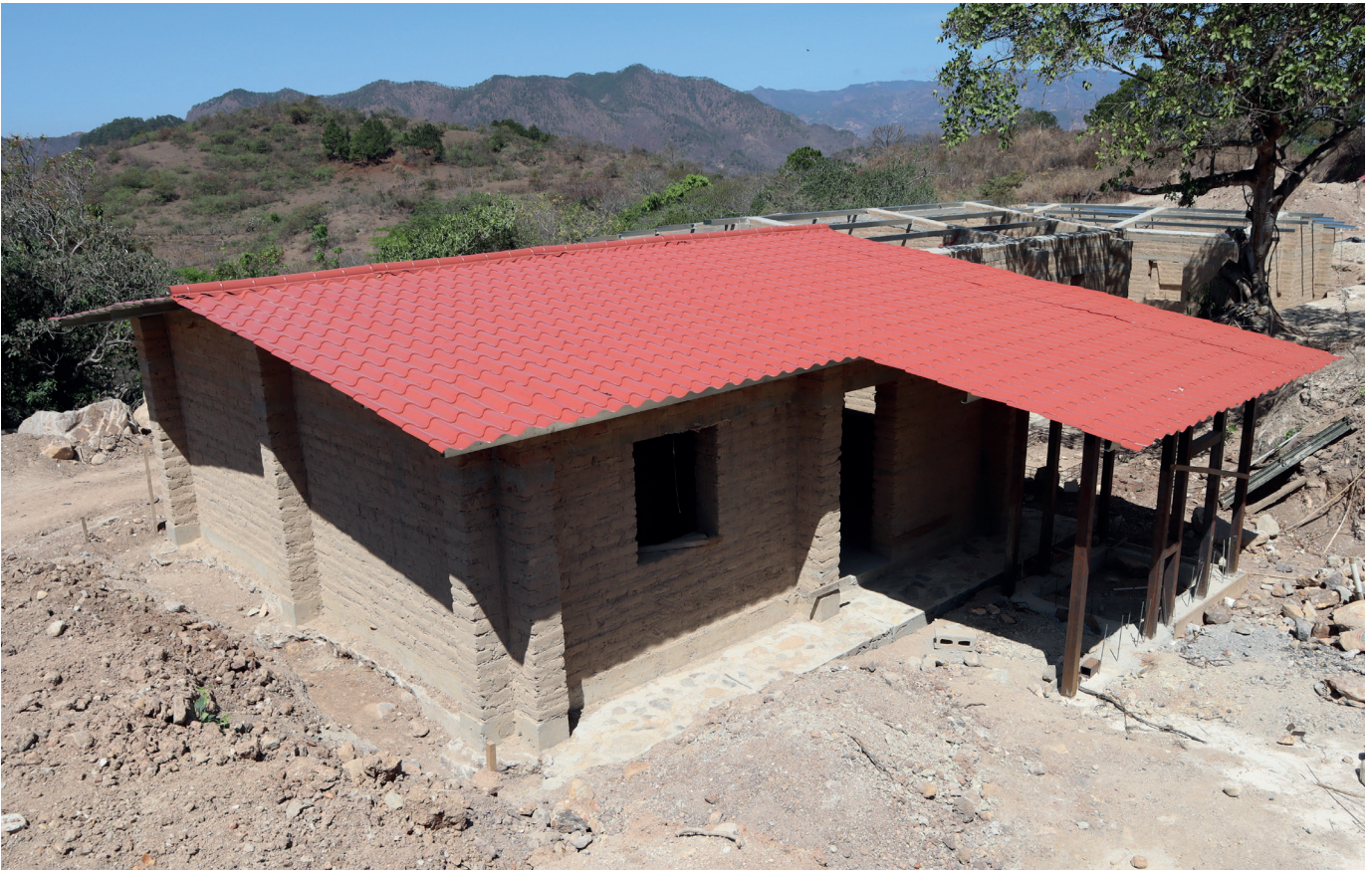
Maisons cours de construction
