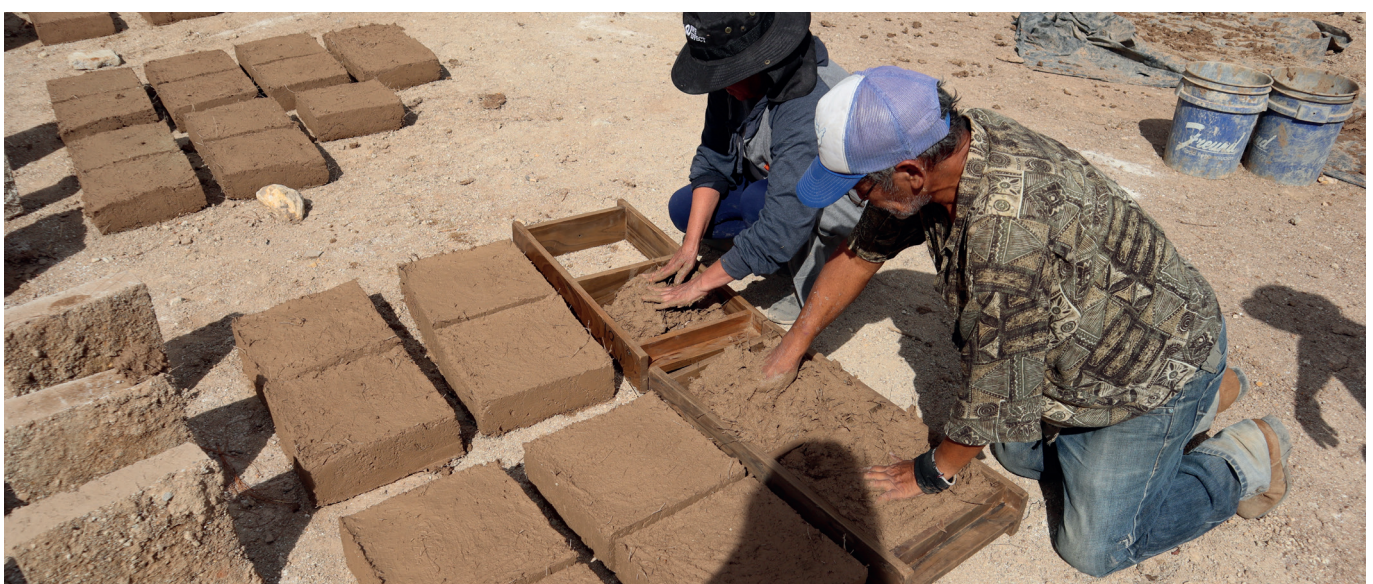
Les associés en produisant des adobes d'essai ↑
