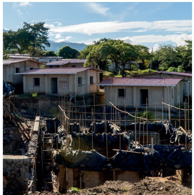
Protection des maisons en construction avec du plastique
