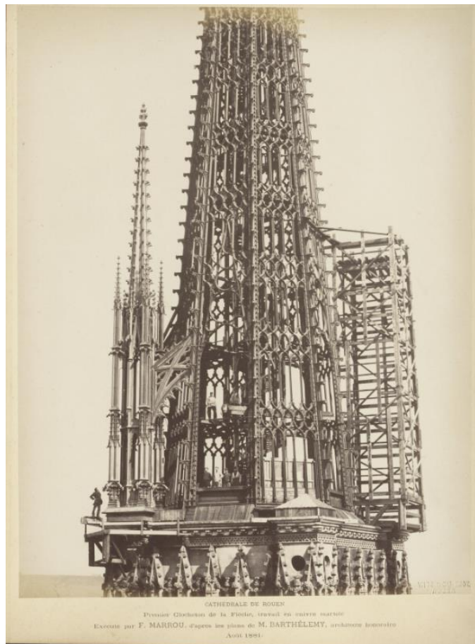
Figure 98 : Pose des clochetons de la cathédrale de Rouen
