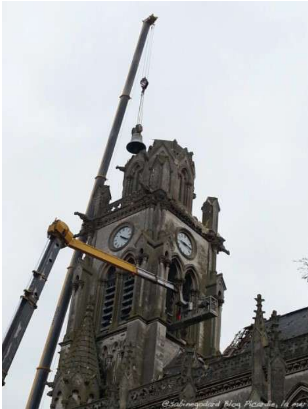
Fig.44. : Sabine Godard, Abbeville, église Saint-Jacques, Jacqueline extraite par le haut avec une grue télescopique, photographie numérique, dans « Jacqueline, la plus ancienne cloche d'Abbeville est sauvée », Blog Picardie, la mer, 25 mars 2013.
