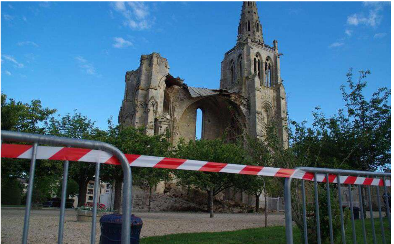
Fig.27 : Alexis Bisson, Crépy-en-Valois, collégiale Saint-Thomas, Une partie de l'église s'est effondrée dans la nuit, photographie numérique, dans Le Parisien, « Crépy-en-Valois : la façade de l'église Saint-Thomas s'est écroulée », 21 juin 2019.
