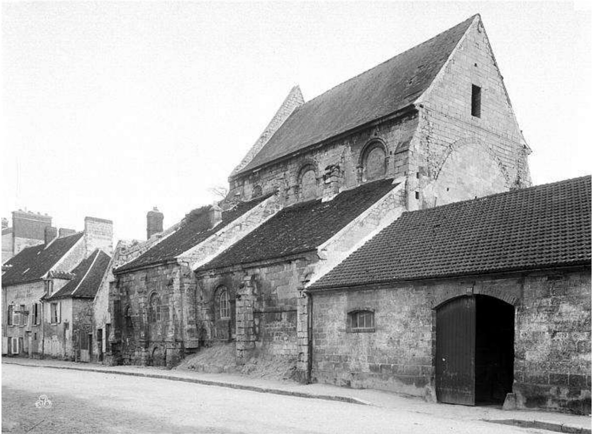
Fig.9 : Jean-Eugène Durand, Creil, collégiale Saint-Évremond, Ensemble nord-ouest, à droite à la grande érigée par les chanoines, clocher et façade démolis, négatif noir et blanc, XIXe siècle, Charenton-le-Pont, Méd. Arch. Pat., MH0011770.
