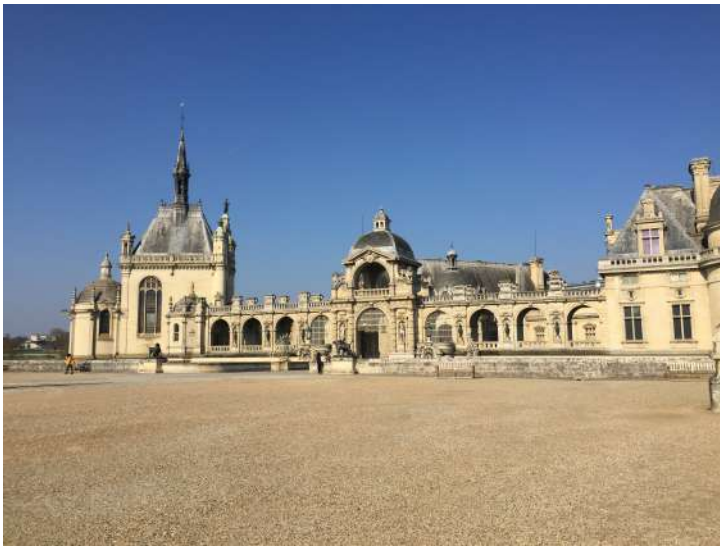
Fig. 12. Vue du château de Chantilly, vue actuelle, crédits : Fanny Brière.
