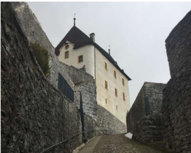
Fig. 61. Vue du château de Valangin, Valangin, vue actuelle,
