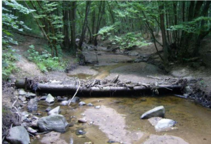
Figure 4. Ensablement provoqué par un seuil de 30 cm de haut sur l'Yzeron (Grosprêtre, 2011).
