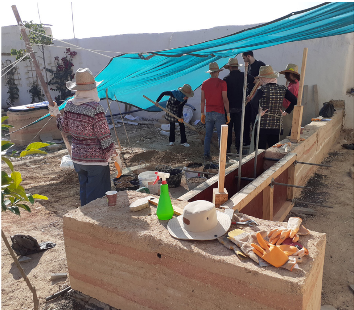
Figure 31a, 31b et 31c : Chantier Participatif à Al Ghota © Hanan Khawandi
