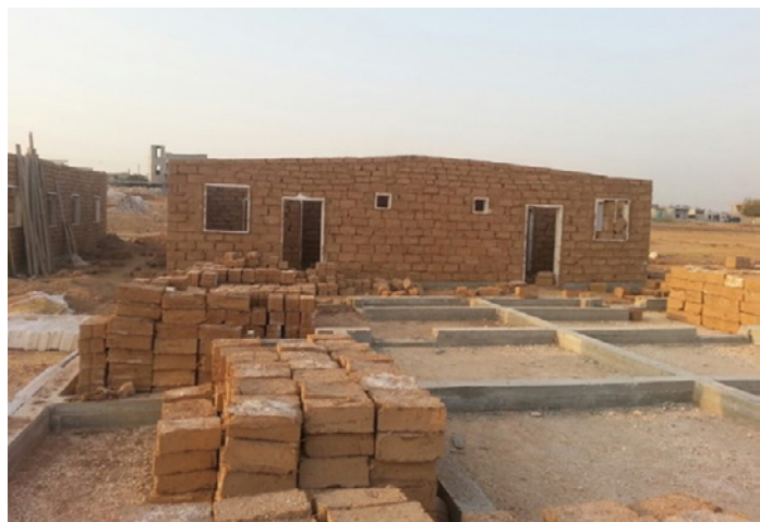
Figure 51 : Construction en terre au village d'AFes © Binaa
