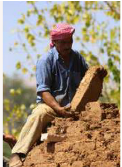
Figure34 : Dome de la Bikaa ©Huda Kasatly
