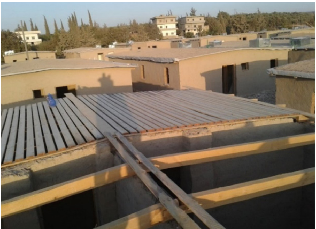
Figure 60a 60b et 60c : les poteaux de la toiture en bois, Village AlFardan © Binaa
