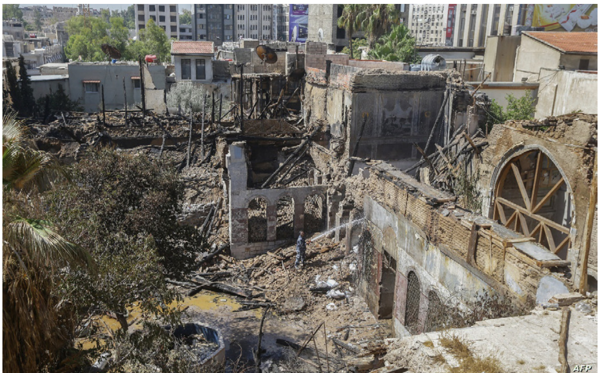
Figure 22 : La ruine de palais traditionnels du quartier de Sarouja, à Damas, qui ont brûlé auparavant à cause d'un incendie survenu le 16 juillet 2023, Source: réseaux sociaux, inconnue.
