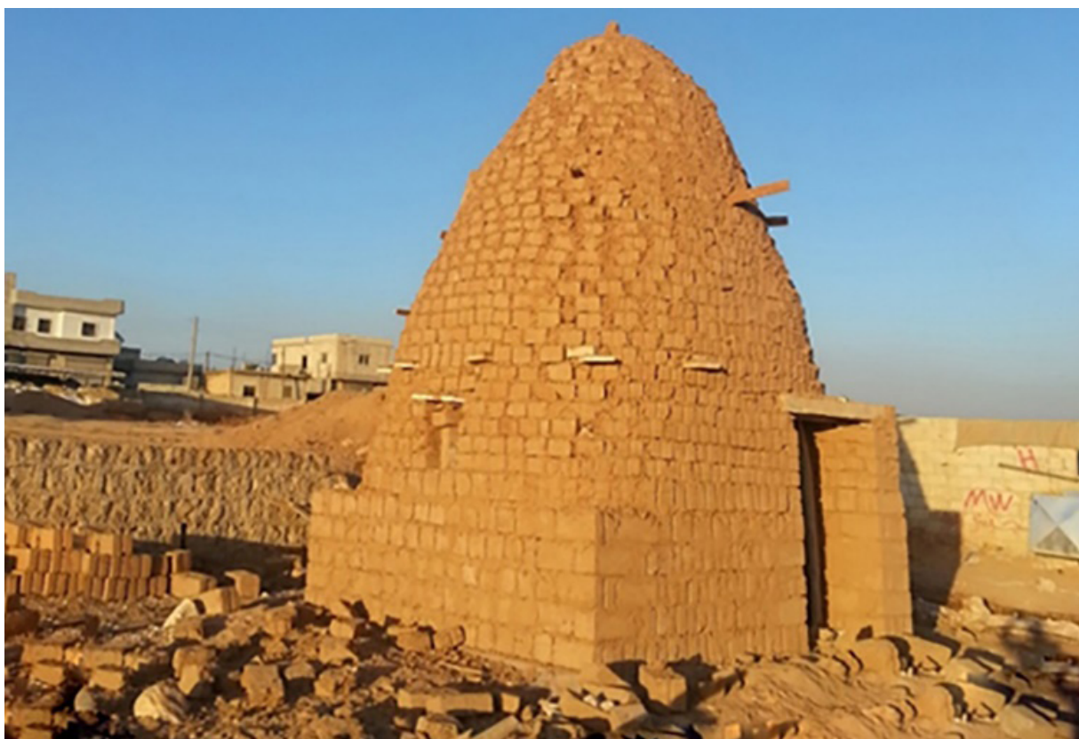
Figure 50 : Un modèle expérimental du toiture en forme de dôme au projet de Afes , mais il n'a pas été approuvé © Binaa
