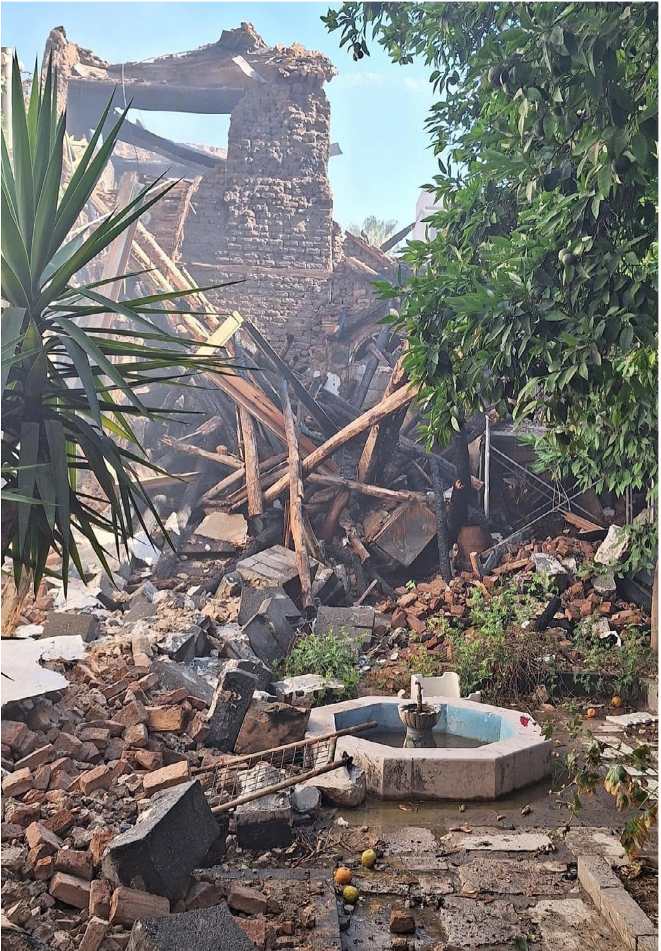
Figure 21 : La ruine de palais traditionnels du quartier de Sarouja, à Damas, qui ont brûlé auparavant à cause d'un incendie survenu le 16 juillet 2023 , Source: réseaux sociaux , inconnue.
