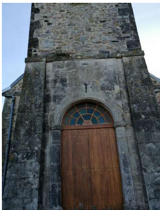
Photographie n°267 : Façade comportant les armoiries de Saint-Martin d'Audouville-1 et 2, prise le 22 oct 2022, par MARIE Jordan.©
