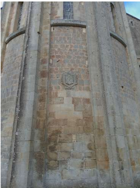
Photographie n°175 : Mur comportant l'armoire Montebourg-2, prise le 6 oct 2022, par MARIE Jordan.©
