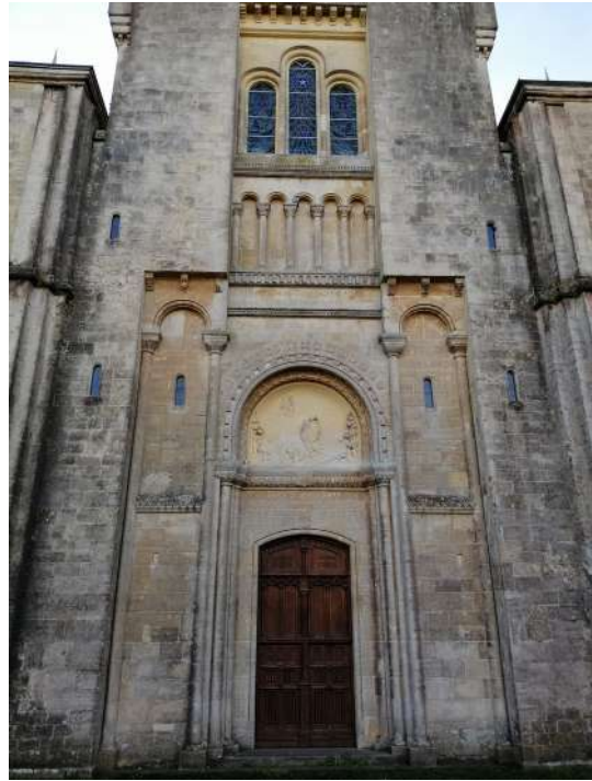
Photographie n°174 : Façade comportant l'armoire Montebourg-1, prise le 6 oct 2022, par MARIE Jordan.©
