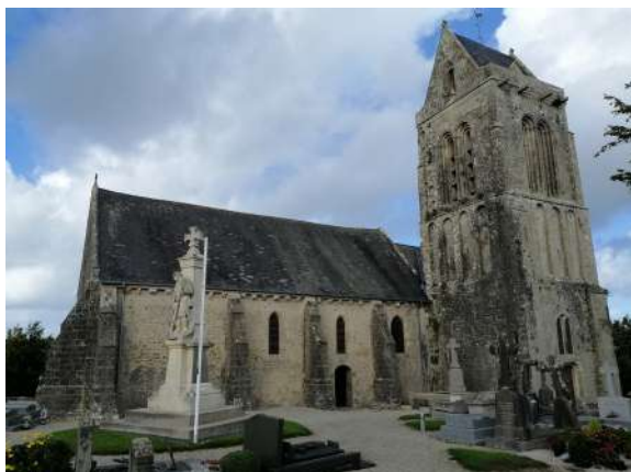
Photographie n°259 : L'église de Saint-Marcouf, vue sud-ouest, prise le 1 oct 2022, par MARIE Jordan.©
