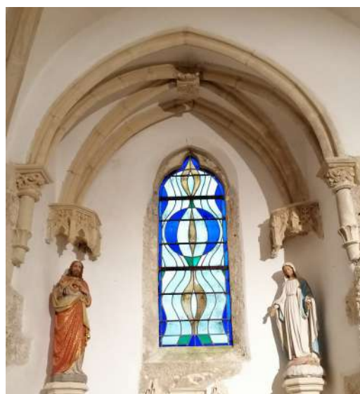
Photographie n°101 : Arcade de la fenêtre qui comporte les armoiries Hémevez-3 et 4, prise le 3 déc 2022, par MARIE Jordan.©
