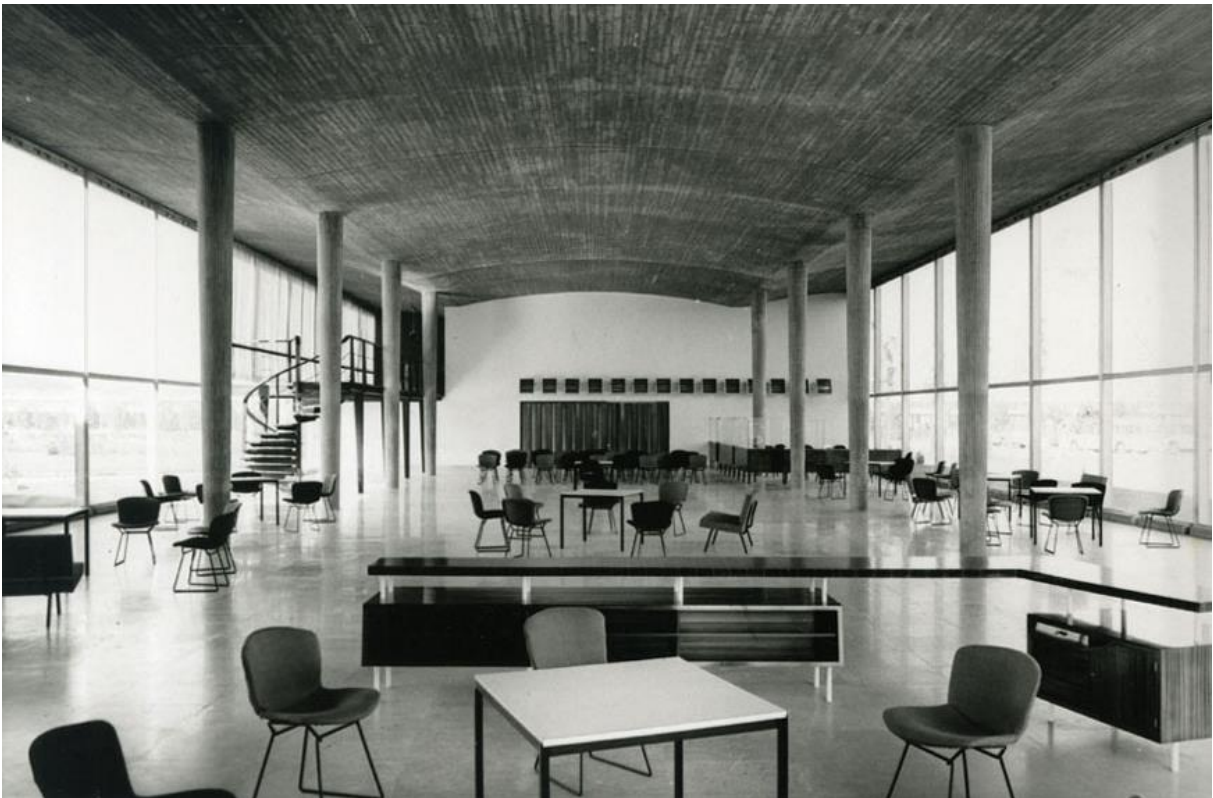
Illustration n° 6 - Architecture de l'usine - Voute en "voile béton" du Hall Georges Besse - Circa 1958
