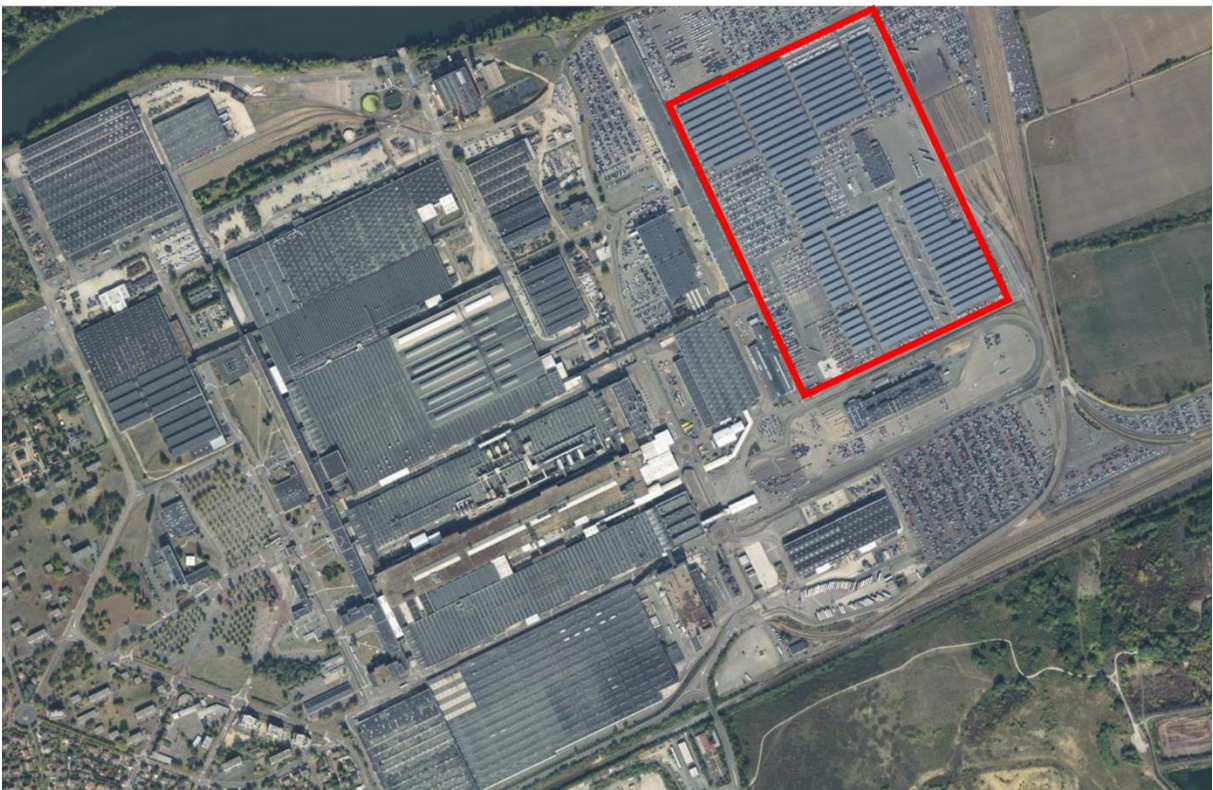
Plan & vue aérienne n° 15 - 2012 – Parc de panneaux photovoltaïques
