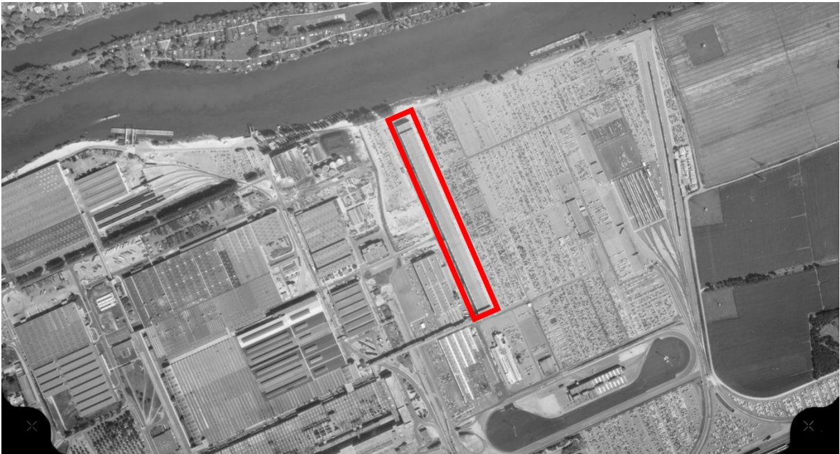
Plan & vue aérienne n° 11 - Juillet 1981 – Bâtiment T (cataphorèse) terminé et opérationnel
