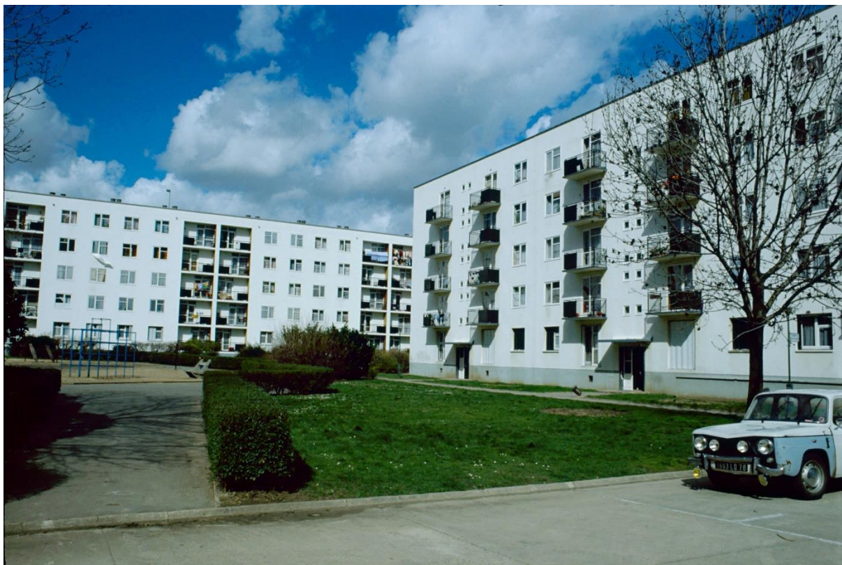
Illustration n° 36 - Quartier des Bouvimont aux Mureaux -fin des années 1970)
