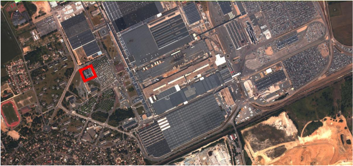
Plan & vue aérienne n° 14 - Juin 2003 – Atelier de réparation Renault Classic (pour les véhicules de collection Renault)
