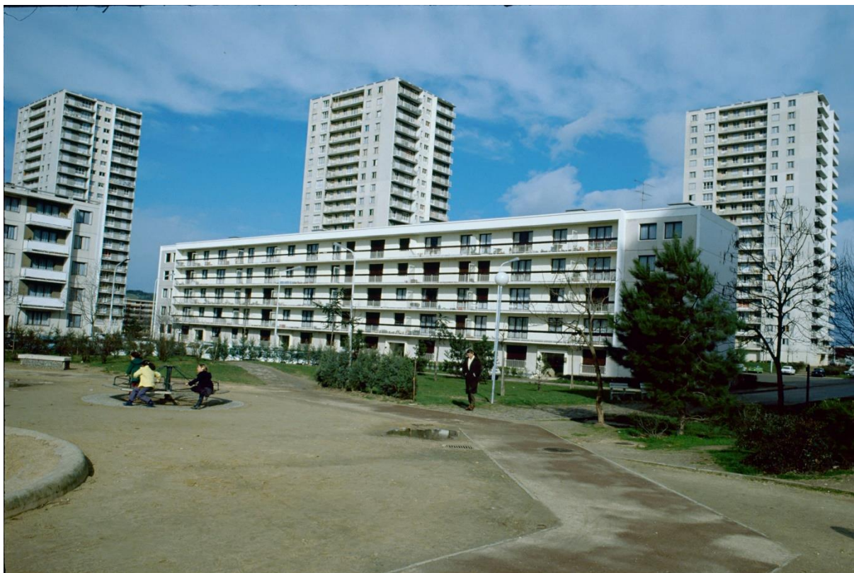
Illustration n° 37 - Quartier des Bouvimont aux Mureaux -fin des années 1970)
