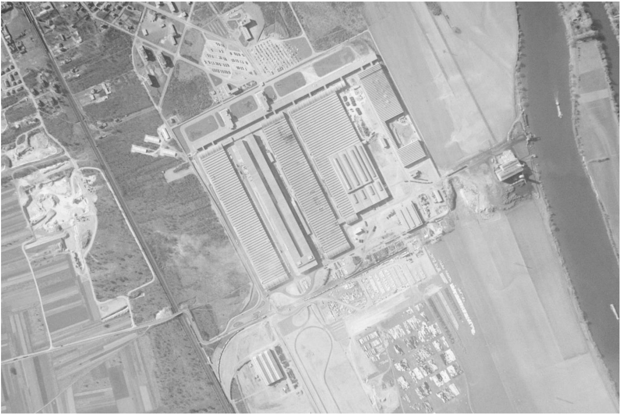
Illustration n° 5 - Vue aérienne de l'usine - 1959
