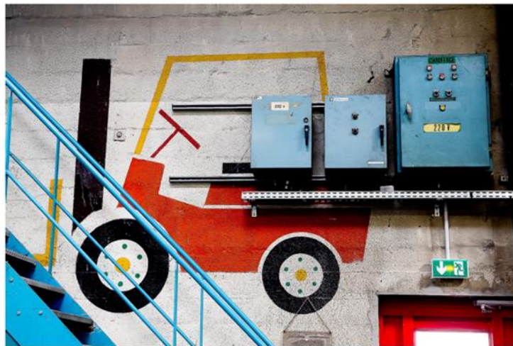
Un car à fourche dans l'escalier Anonyme
