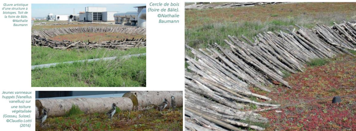
Figure 7 : Illustration de deux composants à disposer en toiture pour constituer des structures à biotopes (tas de branches et souches), Suisse.
